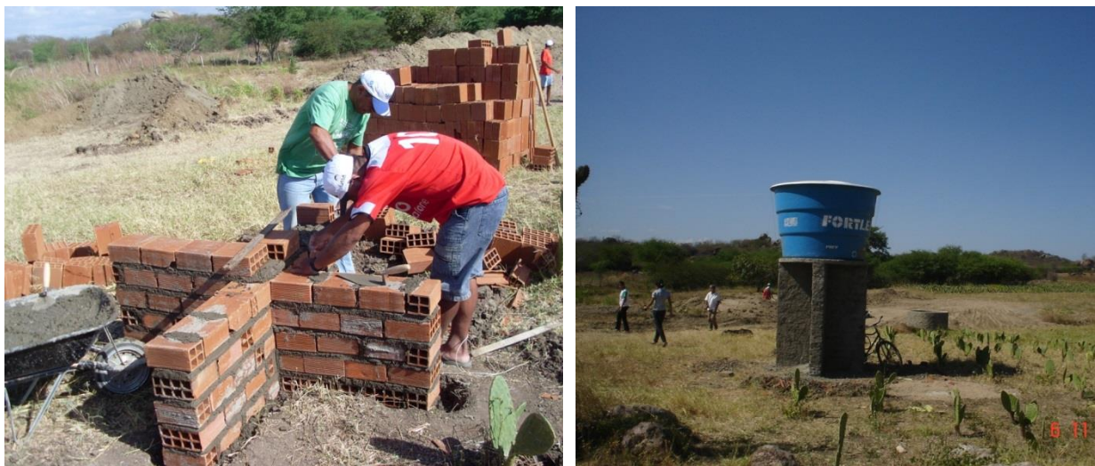
Figura 12: Instalação da caixa d'água
