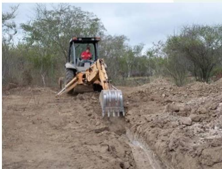
Figura 6: Escavação da vala
