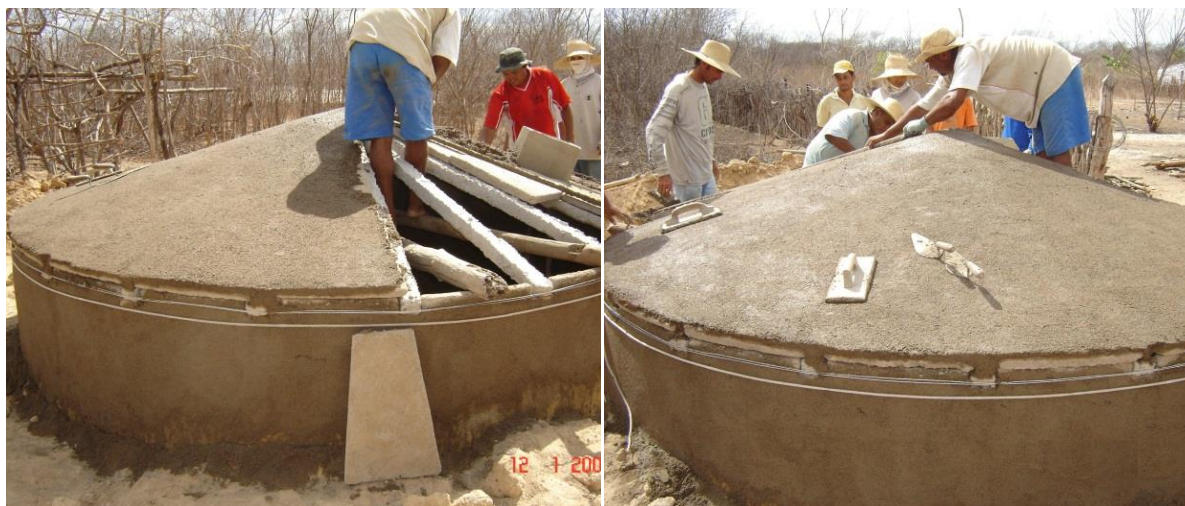
Figura 11: Instalação das placas e reboco do teto da cisterna
