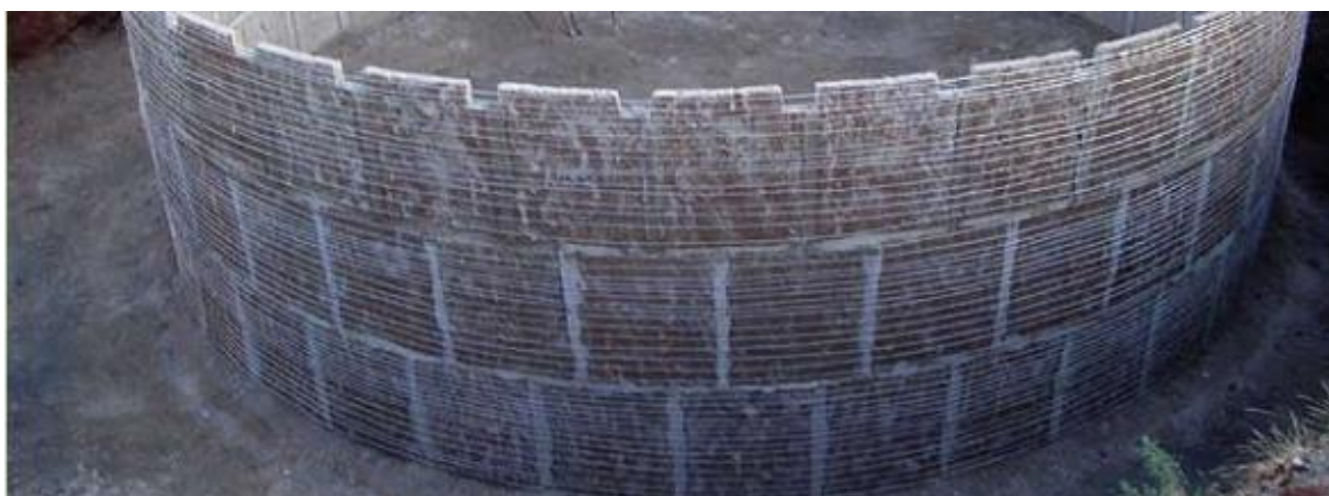
Figura 8: Amarração das paredes
