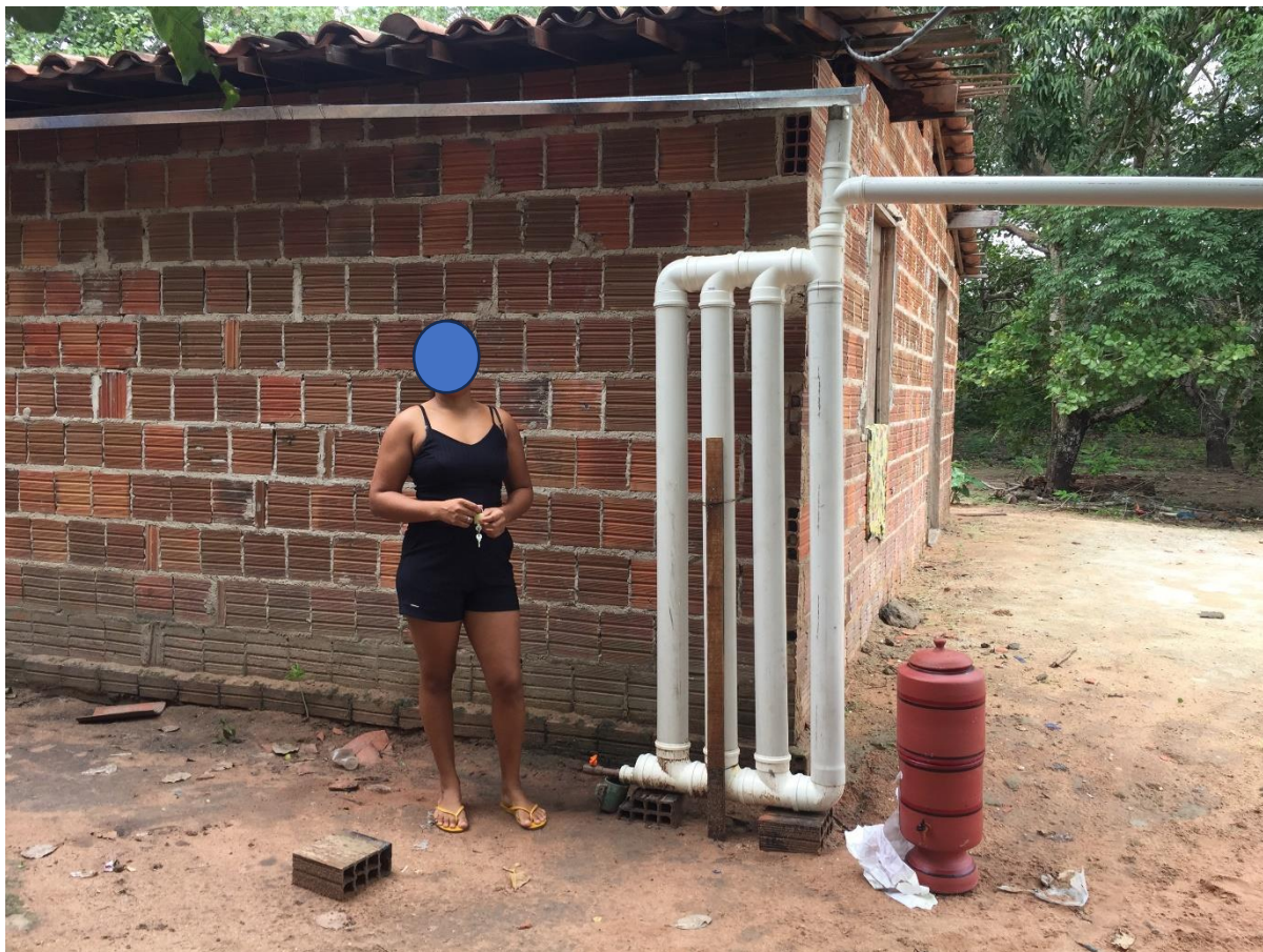
Foto 2: Visualização do dispositivo de descarte, filtro de barro, calha, telhado e beneficiário
