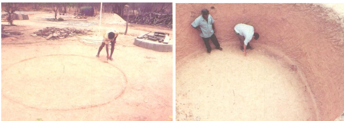
Figura 2: Marcação para escavação do buraco
