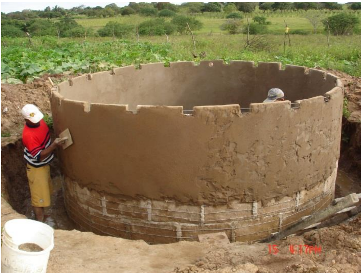
Figura 9: Reboco externo da parede da cisterna
