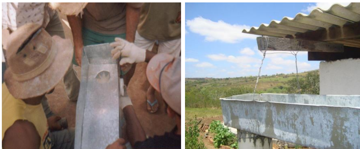
Figuras 12: Fixação das calhas de bica
