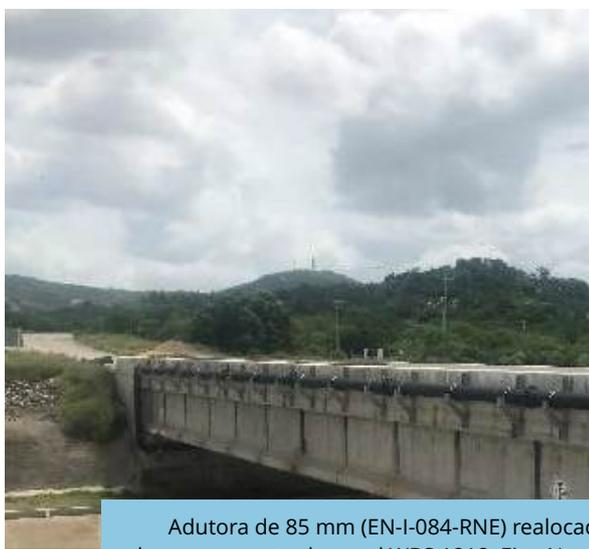
Adutora de 85 mm (EN-I-084-RNE) realocada sobre o segmento de canal WBS 1218, Eixo Norte.
