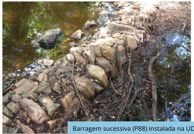
Barragem sucessiva (P88) instalada na UD da VPR Quixeramobim, Trecho II, Eixo Norte do PISF.
