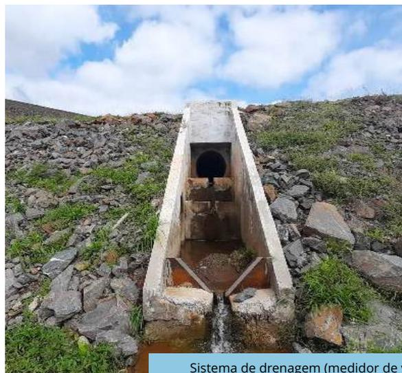
Sistema de drenagem (medidor de vazão) implantado no segmento de canal WBS 1225, Trecho II, Eixo Norte do PISF.
