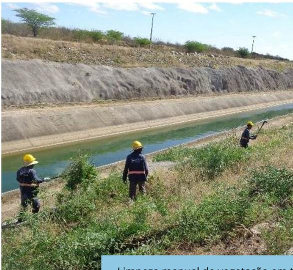
Limpeza manual de vegetação em talude, no segmento de canal WBS 1211.
