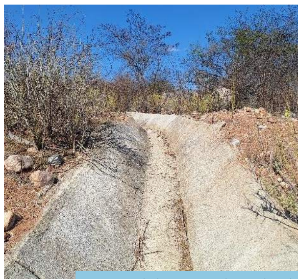
Sistema de drenagem (canaleta) implantado no segmento de canal WBS 2208, Trecho V, Eixo Leste do PISF.
