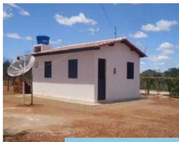
Construção de casas de alvenaria em substituição às de taipa, nas comunidades quilombolas.
