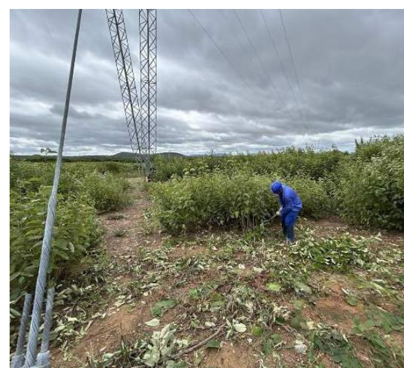
Rebaixamento da cobertura vegetal na base da Torre 24/1, trecho da LT entre SE-04 e SE-05, Trecho V, Leste do PISF.
