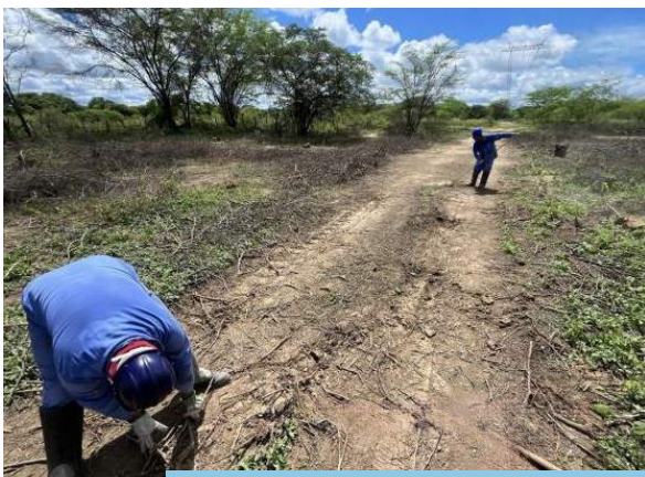
Limpeza na faixa de servidão da linha de transmissão do Eixo Leste com a cobertura vegetal removida.
