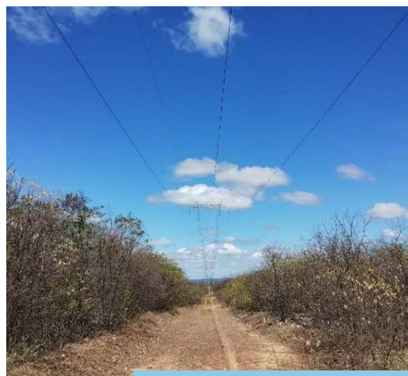
Acompanhamento da situação em trecho da LT, próximo ao segmento de canal WBS 1214, Trecho I, Eixo Norte do PISF.
