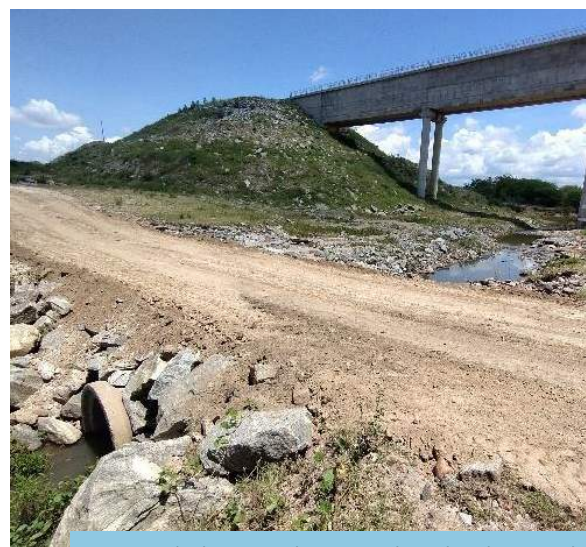
Sistema de drenagem (bueiro) implantado sobre estrada de serviço próximo ao aqueduto Jacaré (WBS 2305), Trecho V, Eixo Leste do PISF.
