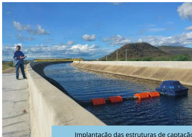
Implantação das estruturas de captação e adução de água do sistema de irrigação da VPR Baixio dos Grandes.
