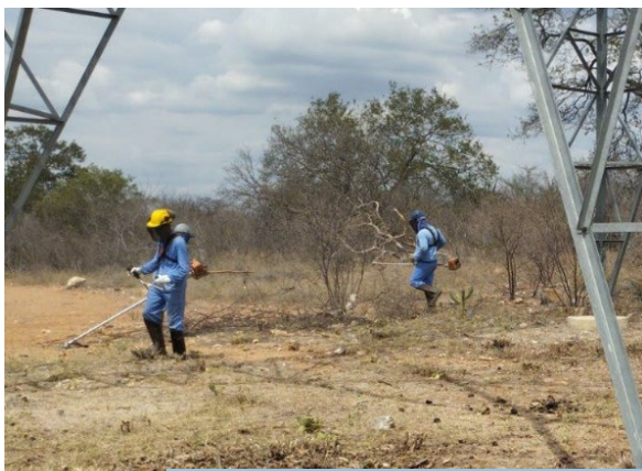
Limpeza na faixa de servidão da linha de transmissão do Eixo Norte com a cobertura vegetal removida (nov/2024).
