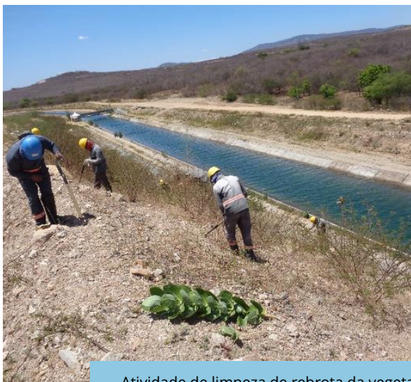
Atividade de limpeza de rebrota da vegetação no segmento de canal WBS 2225, Trecho V, Eixo Leste do PISF.
