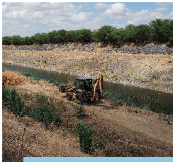
Manutenção de estrada de O&M, no segmento de canal WBS 1234, Trecho I, Eixo Norte do PISF.
