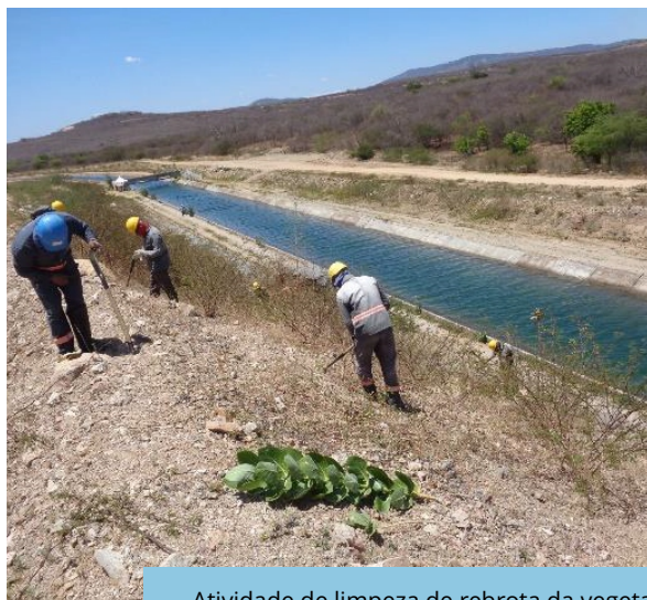
Atividade de limpeza de rebrota da vegetação no segmento de canal WBS 2225, Trecho V, Eixo Leste do PISF.
