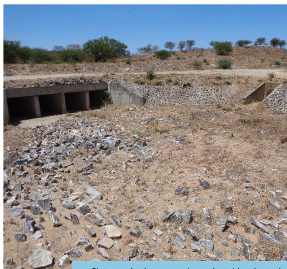
Sistema de drenagem (overchute) implantado no segmento de canal WBS 2227, Trecho V, Eixo Leste do PISF.
