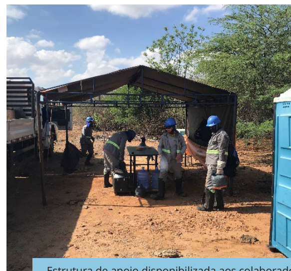
Estrutura de apoio disponibilizada aos colaboradores, na frente de serviço do segmento de canal WBS 1224, Trecho I, Eixo Norte do PISF.
