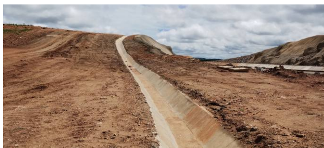
Drenagem superficial para contenção de processos erosivos no segmento de canal 2 (WBS 4224). Município de Cajazeiras/PB.
