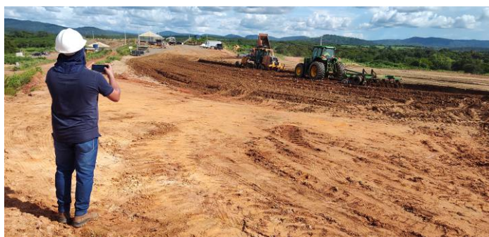
Acompanhamento das atividades de terraplenagem no Canal 6B (WBS 4232). Município de Cachoeira dos Índios/PB.
