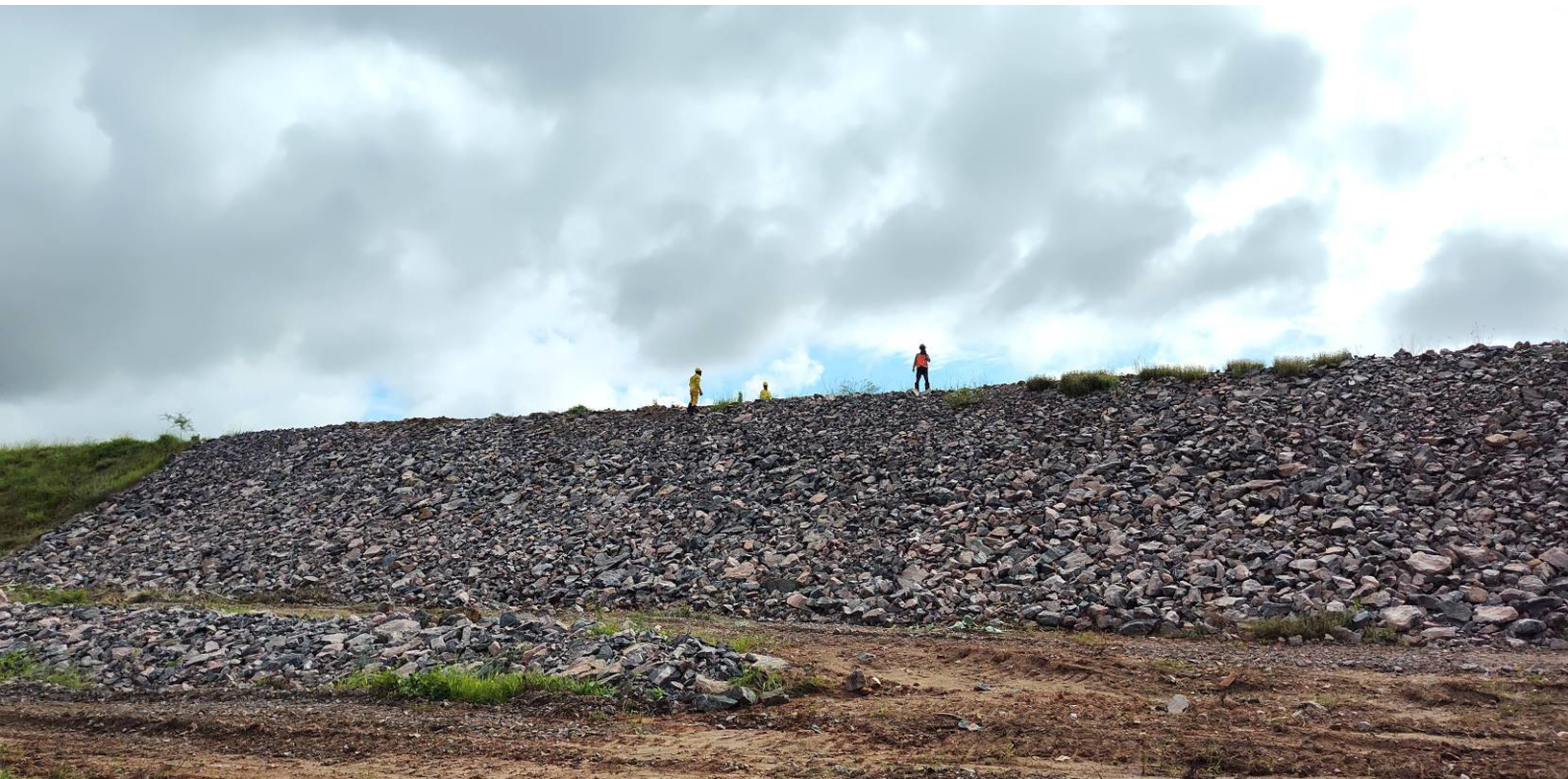
Enrocamento de talude no segmento do canal 6B (WBS 4232). Município de Cachoeira dos Índios/PB.
