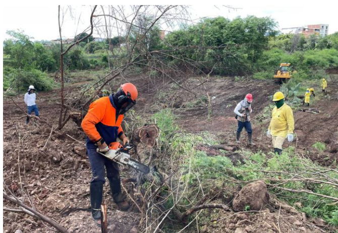
Supressão semimecanizada em área de implantação do canal 14B (WBS 4240) Município de Uiraúna/PB.
