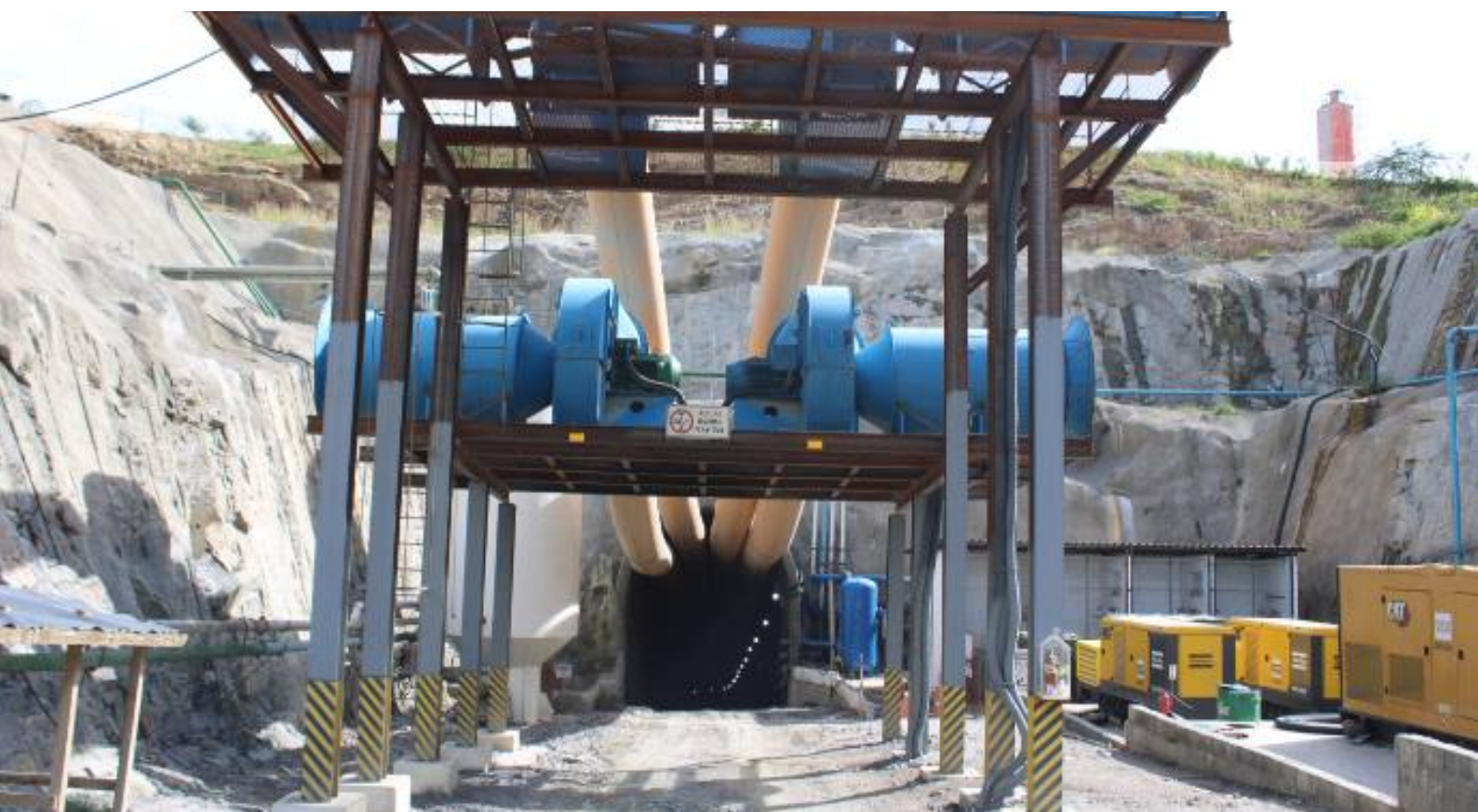
Janela do Túnel Major Sales (WBS 4430). Município Major Sales/RN.
