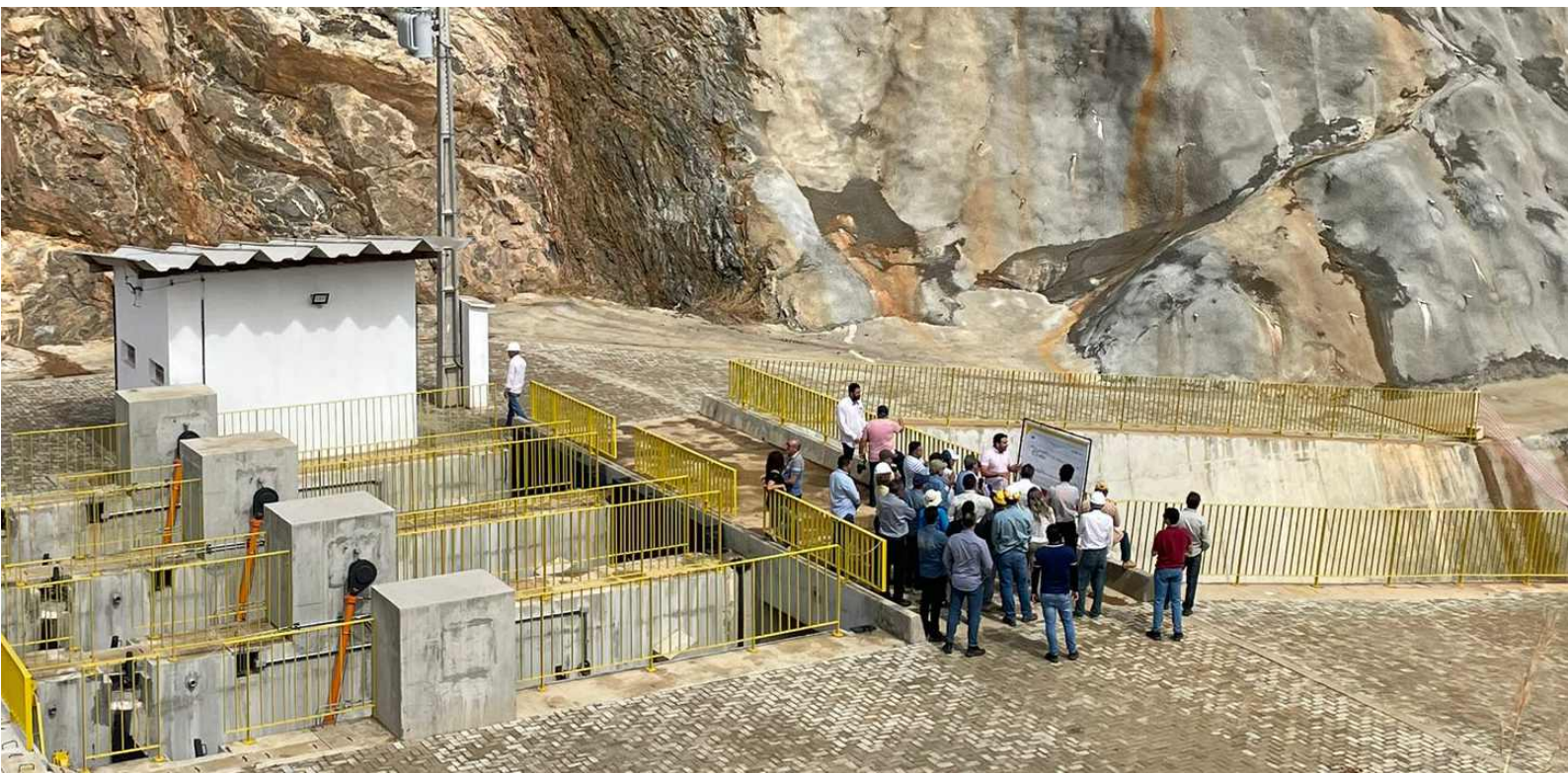
Visita técnica à estrutura de controle do Reservatório Caiçara, início do Segmento de Canal 01.
