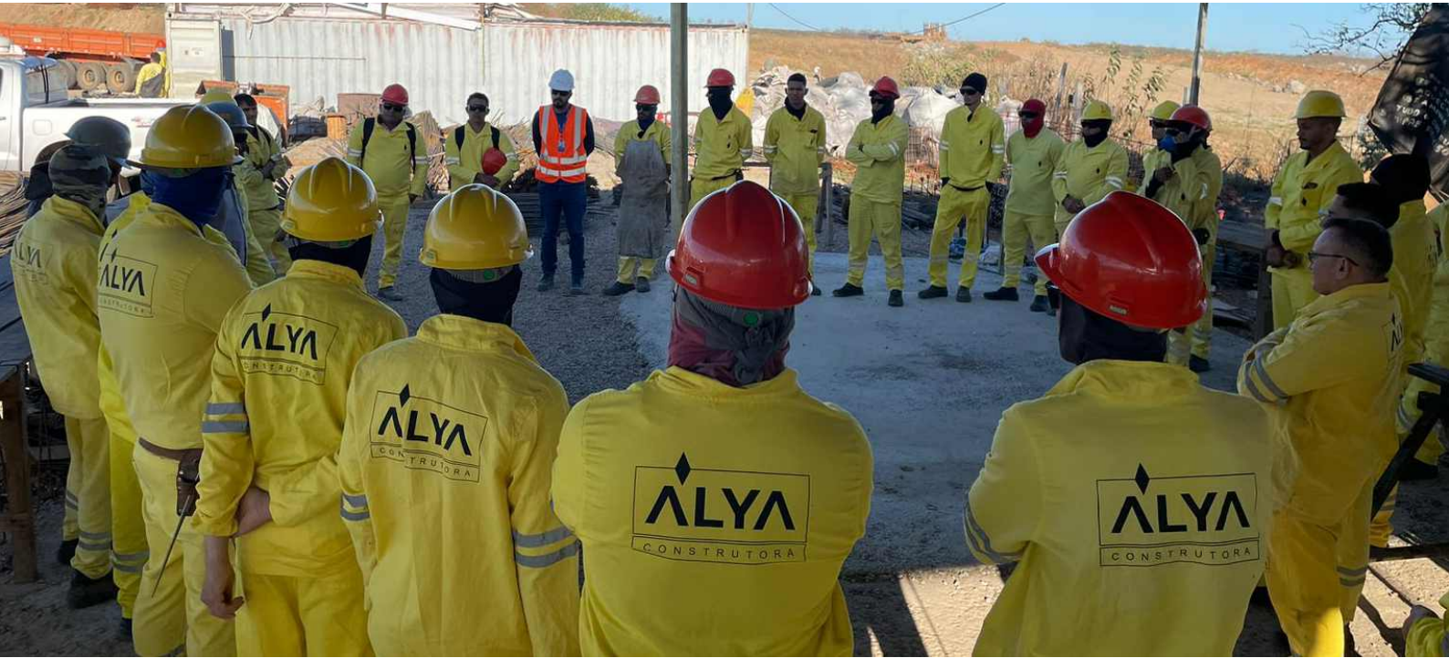
Diálogo Diário de Segurança com o tema de comemoração do Dia dos Pais na Central de Armação do Canteiro Central de Obras do Ramal do Apodi.
