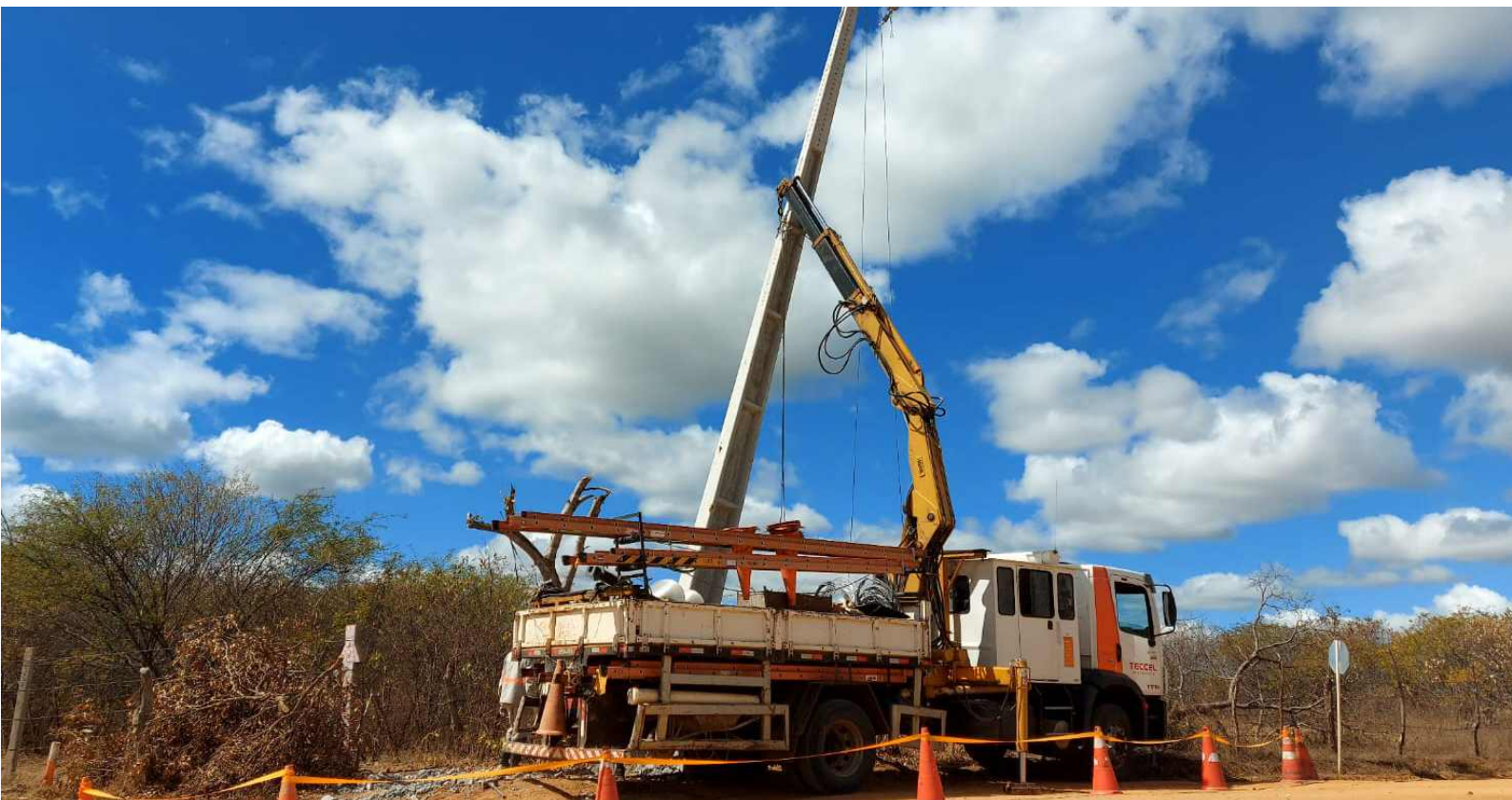
Remoção de poste de energia elétrica no Segmento de Canal C8.
