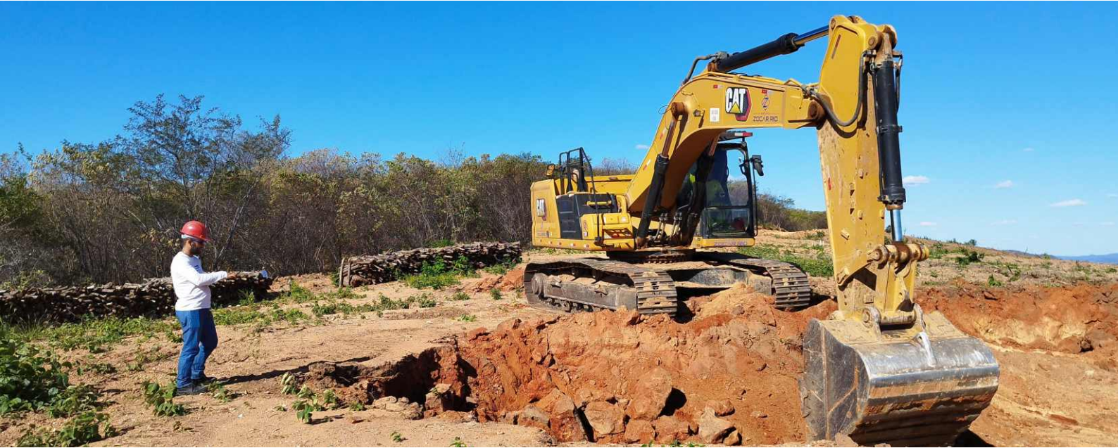
Escavação em caixa de empréstimo no Segmento de Canal C3.
