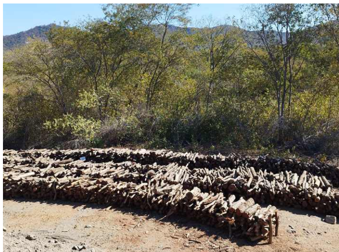
Material lenhoso resultante das ações de supressão vegetal empilhado no Segmento de Canal C3.
