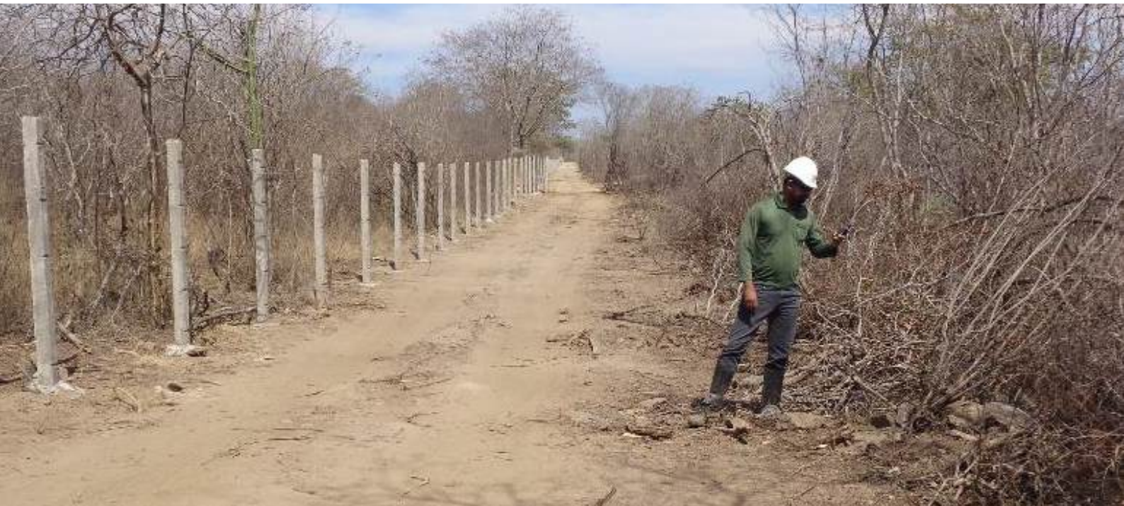
Levantamento da faixa de supressão vegetal para implantação das cercas no entorno do Res. Ipojuca. Arcoverde/PE.
