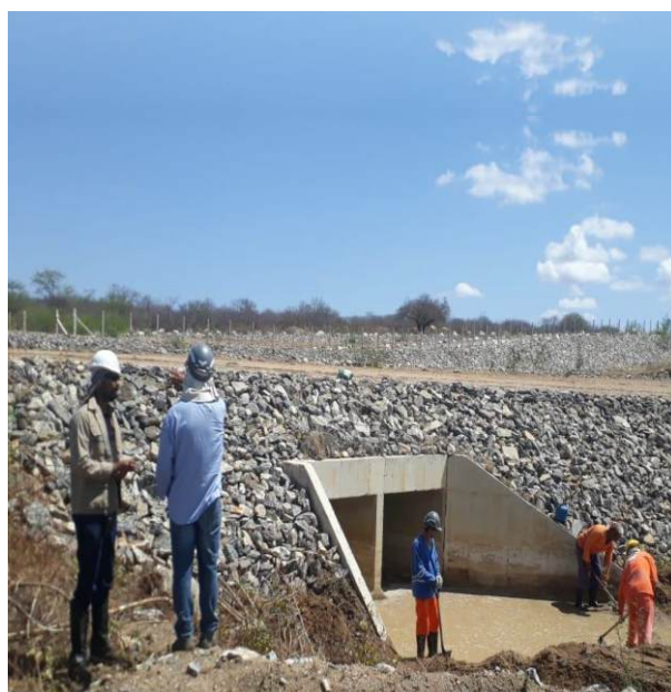
Acompanhamento dos serviços de manutenção e limpeza de bueiros e overchutes, no segmento de canal C8.4, em realização pelo CFG.
