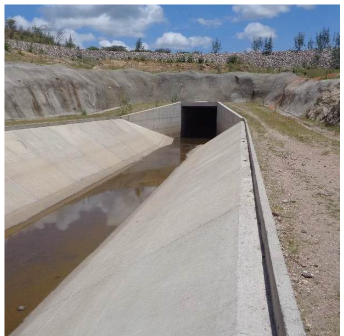
Emboque do túnel Bom Nome, município de Sertânia/PE.
