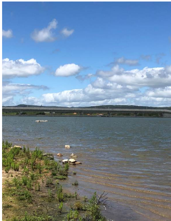
Vista a jusante da Barragem Ipojuca.
