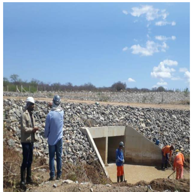
Acompanhamento dos serviços de manutenção e limpeza de bueiros e overchutes, no segmento de canal C8.4, em realização pelo CFG.
