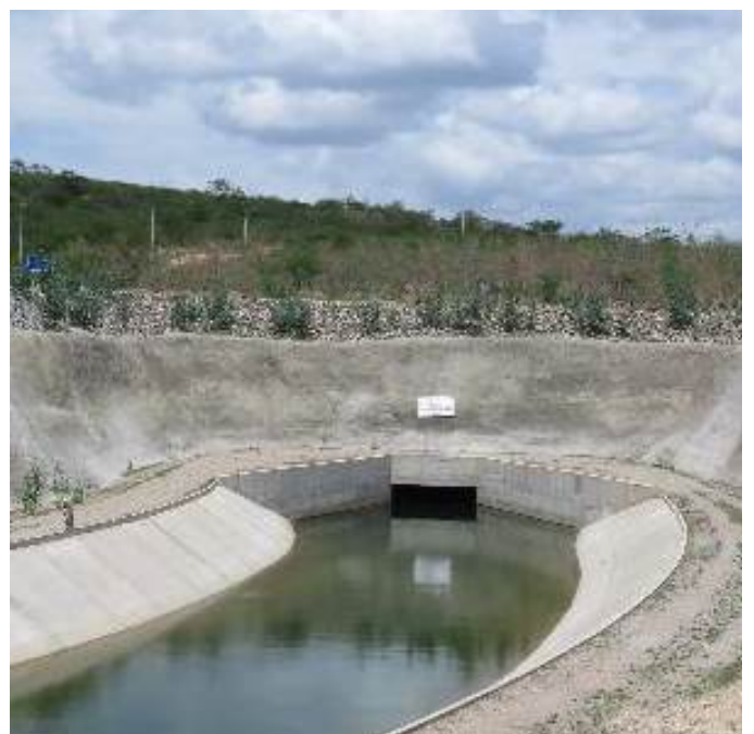
Desemboque do túnel Tigre, município de Sertânia/PE.
