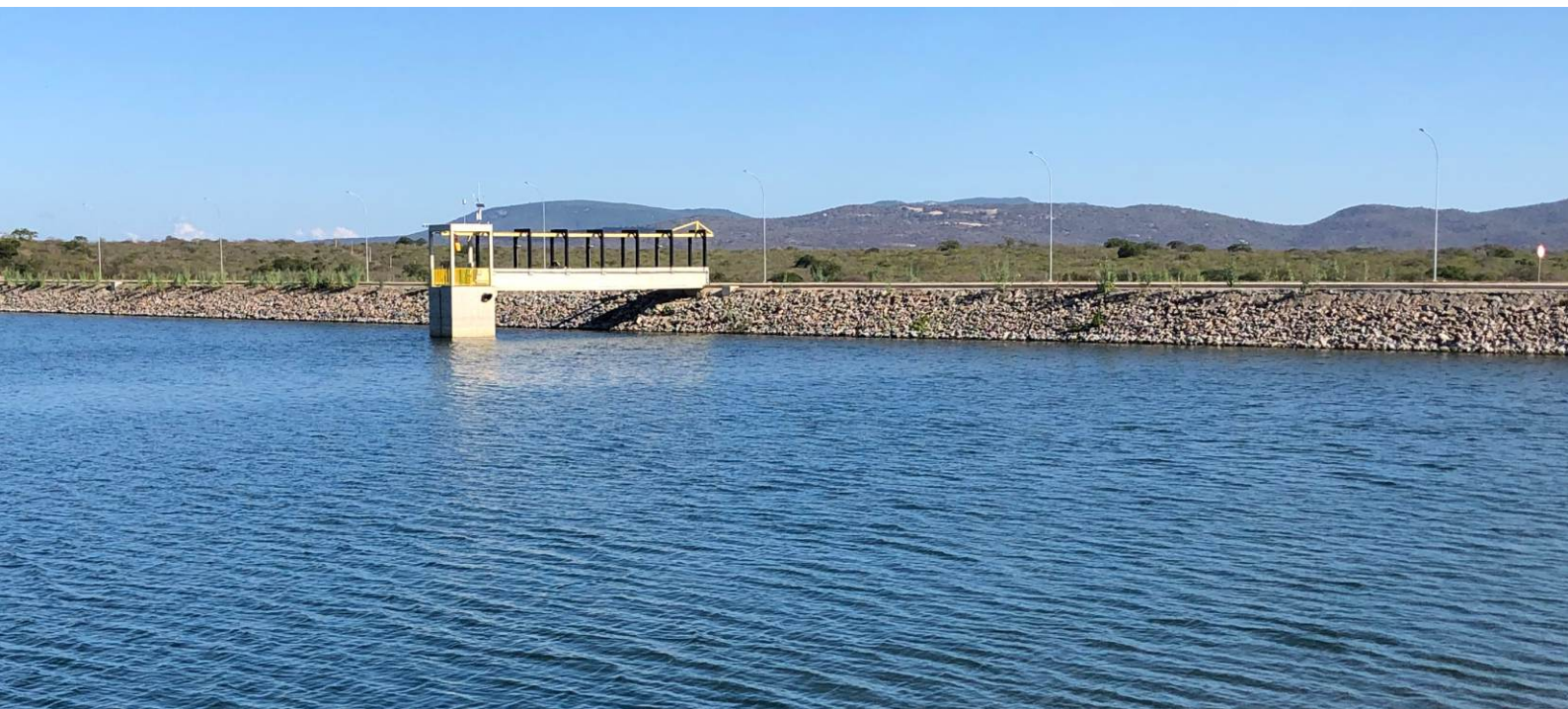
Barragem dos Góis.
