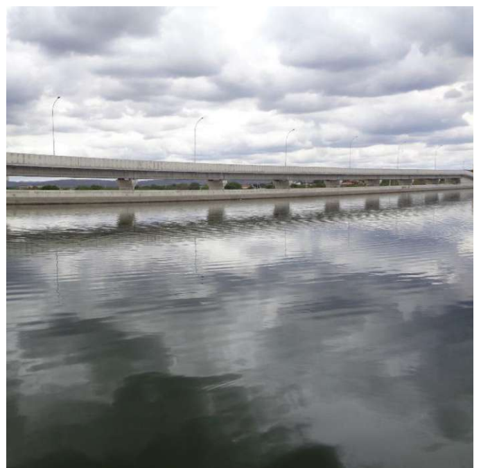
Registro Fotográfico: Reservatório Ipojuca, município de Arcoverde/PE.
