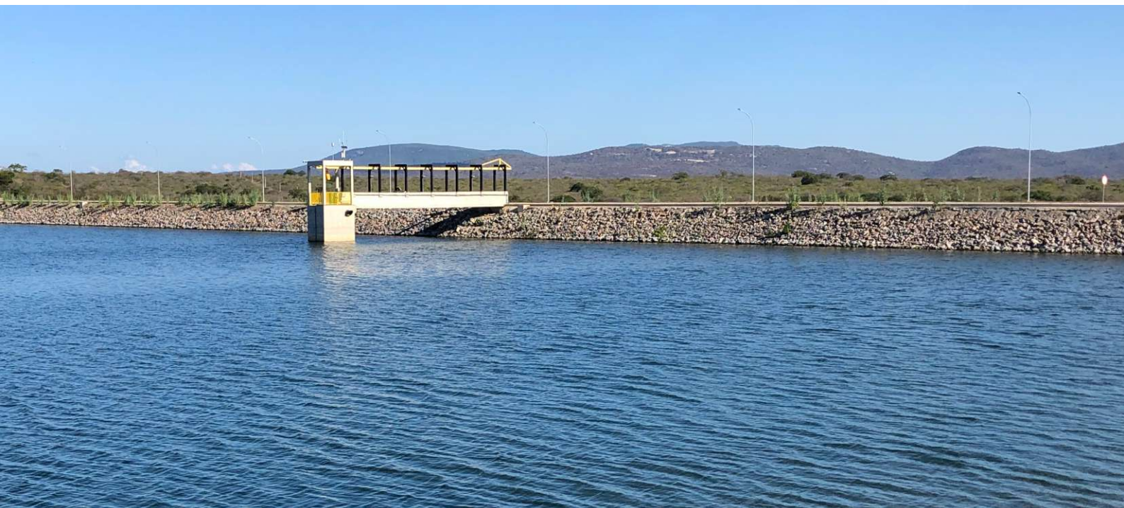
Barragem dos Góis.
