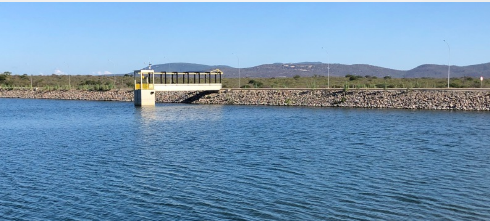
Barragem dos Góis.
