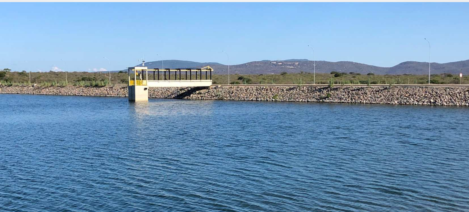
Barragem dos Góis.
