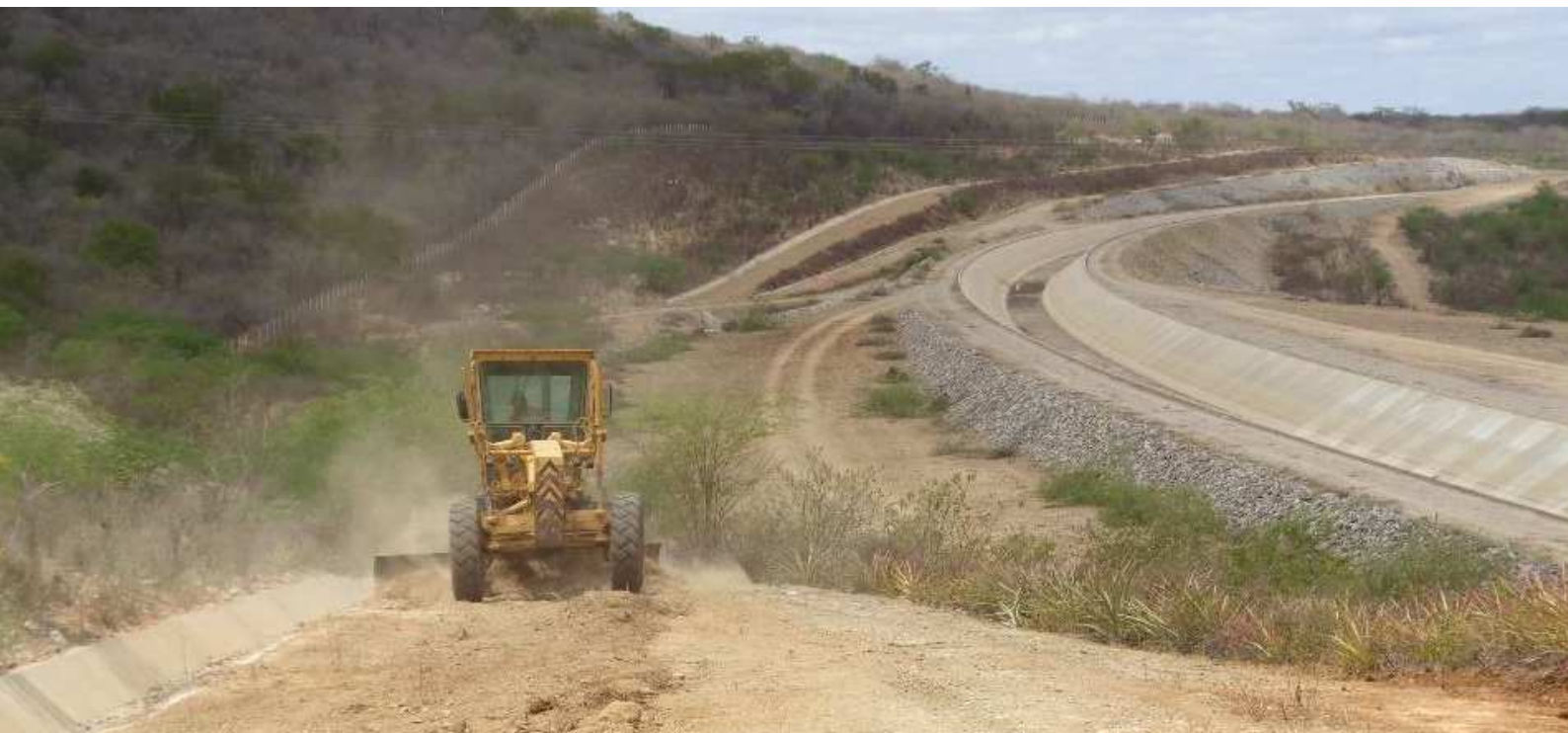
Melhoramento de estrada de serviço às margens do segmento de canal C5. Sertânia/PE.
