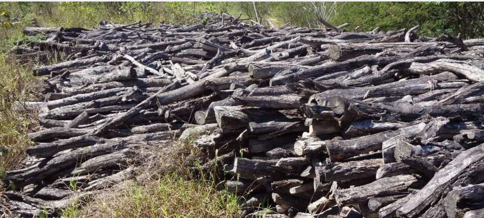
Material lenhoso oriundo das atividades de supressão vegetal no segmento de canal C3. Sertânia/PE.
