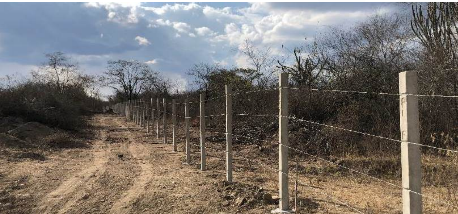
Cercamento implantado no entorno do reservatório Ipojuca. Arcoverde/PE. Serviços de cercamento concluídos em outubro/2023.
