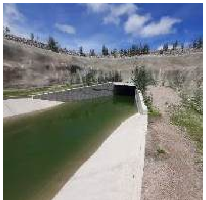
Desemboque do túnel Ipojuca II, município de Arcoverde/PE.
