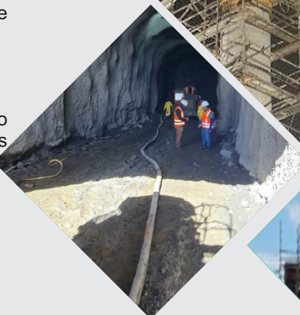
Túnel Major Sales: Execução da escavação na janela de emboque
