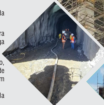
Túnel Major Sales: Execução da escavação na janela de emboque
