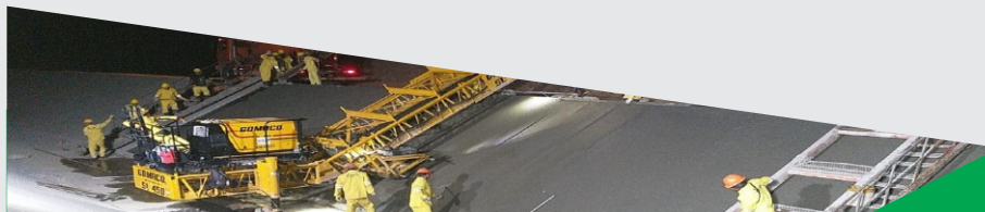
Execução de Placas de Concreto (Noturno)
