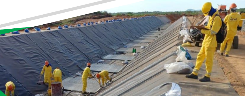
Canal 8: Execução de geomembrana
