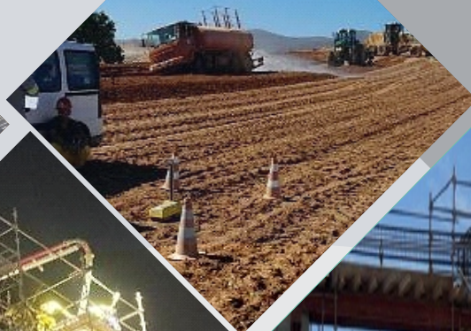
Execução de ensaio da camada de aterro compactado
