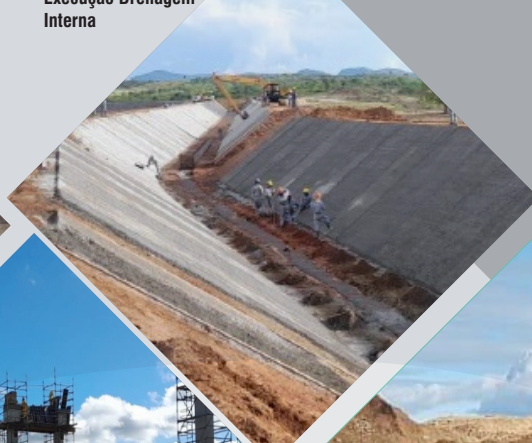
Execução Drenagem Interna
