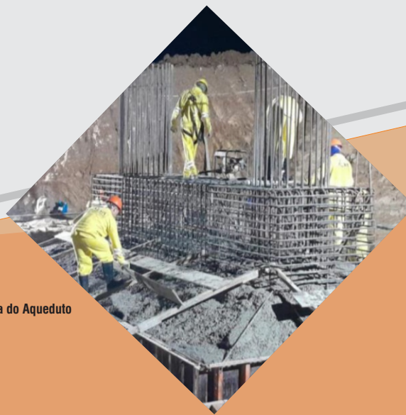
Aqueduto Pitombeira: Execução da mesoestrutura
