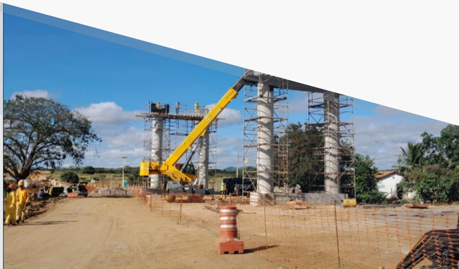
Aqueduto Pitombeira: Execução da mesoestrutura
