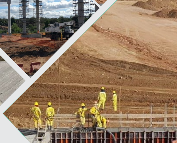
Execução das paredes e laje superior do Bueiro 5
