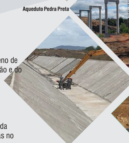
Proteção de Taludes externos
