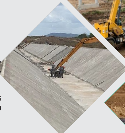
Proteção de Taludes externos
