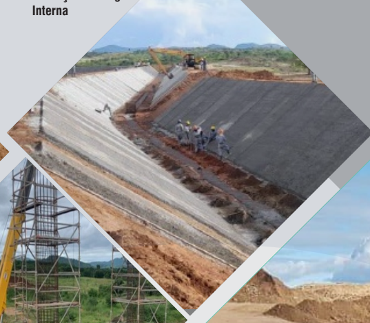
Execução Drenagem Interna
