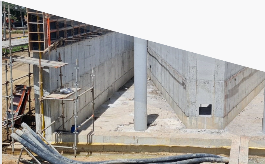
Estrutura de Controle Km 30 - Execução da forma de armação da EC.
