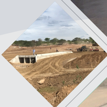
Execução de Bueiro
