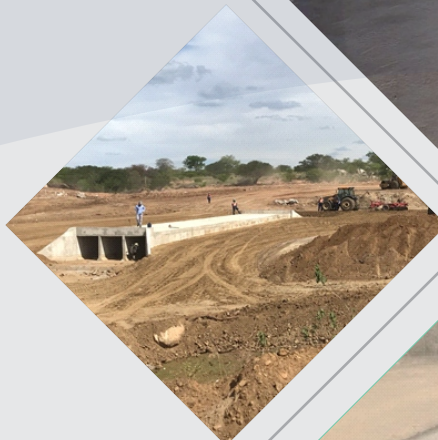
Execução de Bueiro
