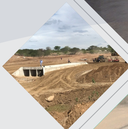
Execução de Bueiro
