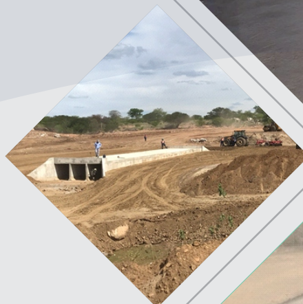
Execução de Bueiro
