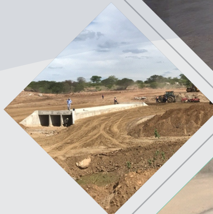
Execução de Bueiro
