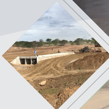
Execução de Bueiro
