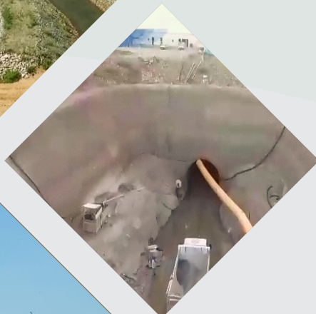
Emboque do Túnel Ipojuca
