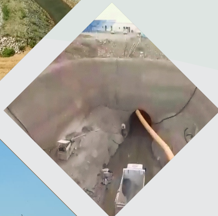
Emboque do Túnel Ipojuca
