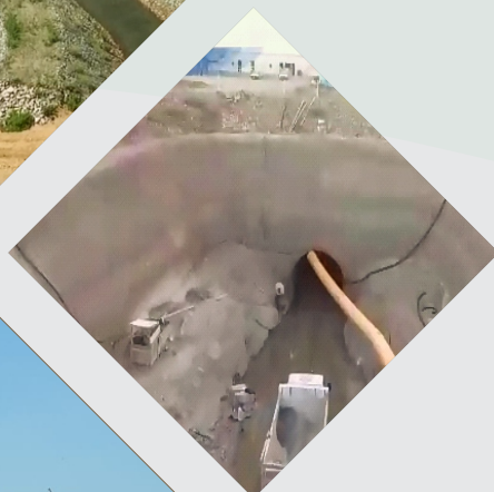
Emboque do Túnel Ipojuca
