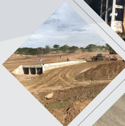
Execução de Bueiro
