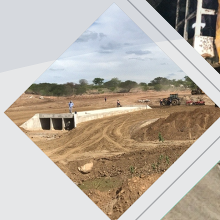
Execução de Bueiro
