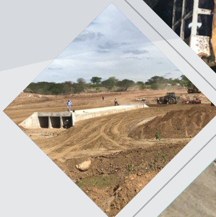
Execução de Bueiro
