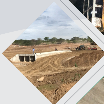
Execução de Bueiro
