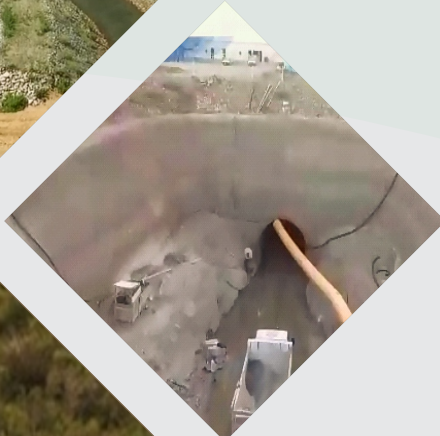
Emboque do Túnel Ipojuca
