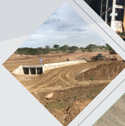
Execução de Bueiro
