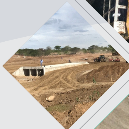
Execução de Bueiro
