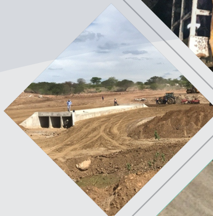
Execução de Bueiro
