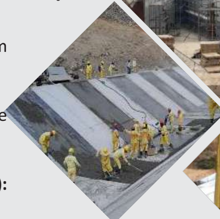
Execução de Geomembrana e placas de proteção
