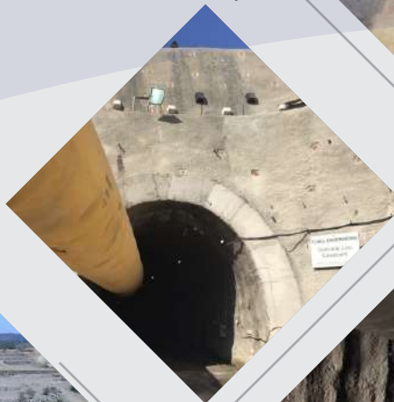
Túnel Eng. Giancarlo Lins Cavalcanti - Emboque
