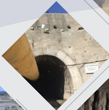
Túnel Eng. Giancarlo Lins Cavalcanti - Emboque
