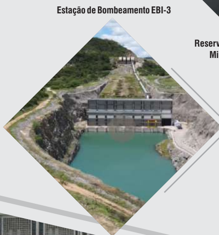
Estação de Bombeamento EBI-3
