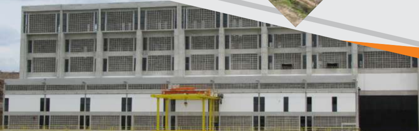
Estação de Bombeamento EBI-1
