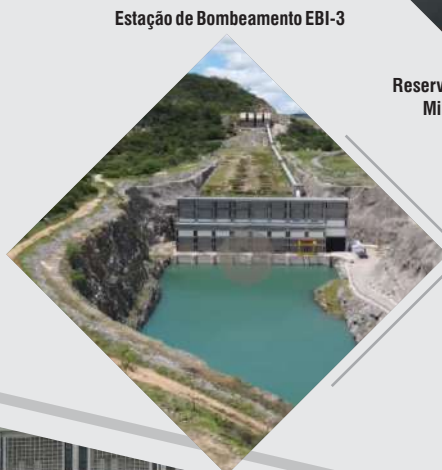
Estação de Bombeamento EBI-3
