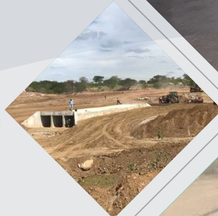
Execução de Bueiro
