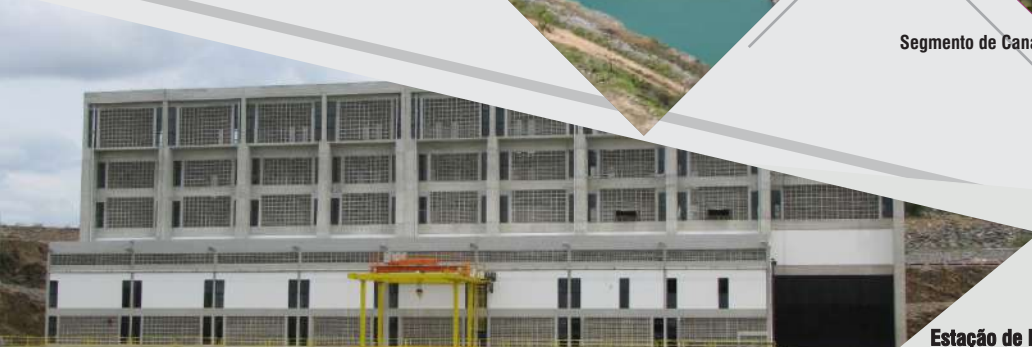
Estação de Bombeamento EBI-1
