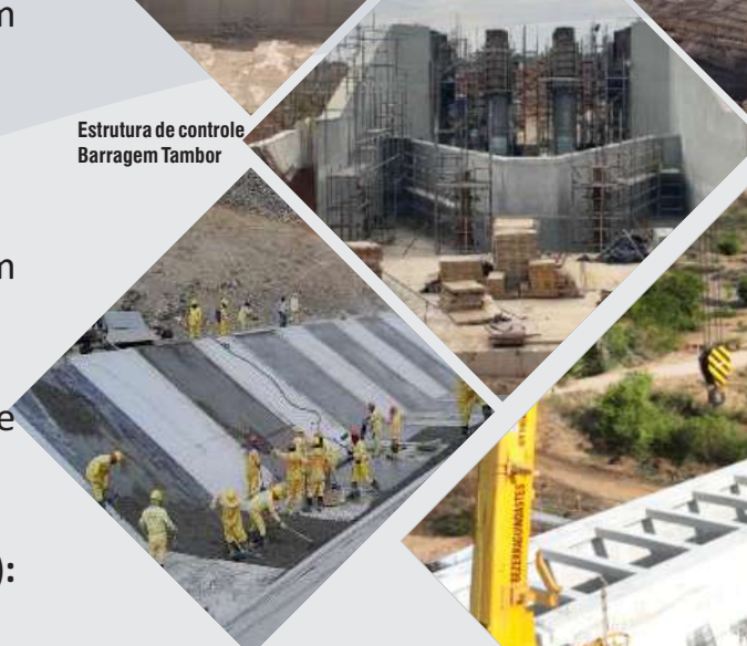
Execução de Geomembrana e placas de proteção
