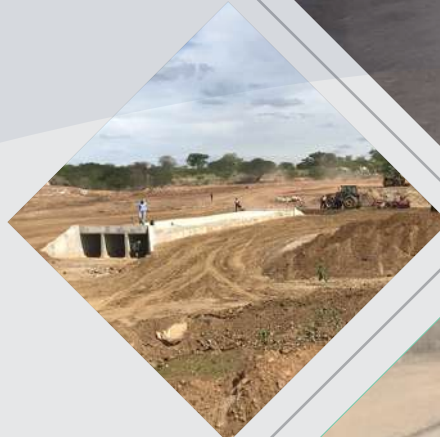
Execução de Bueiro
