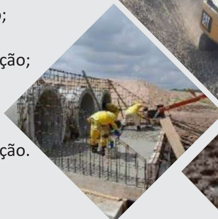
Execução de Bueiro
