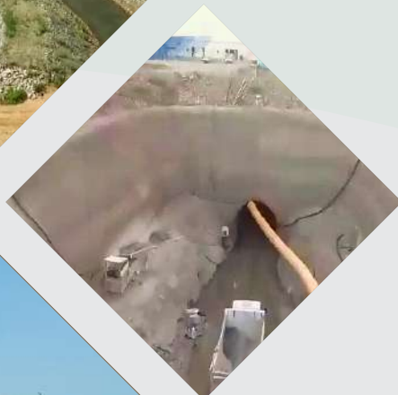
Emboque do Túnel Ipojuca
