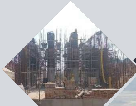
Execução de forma de armação
