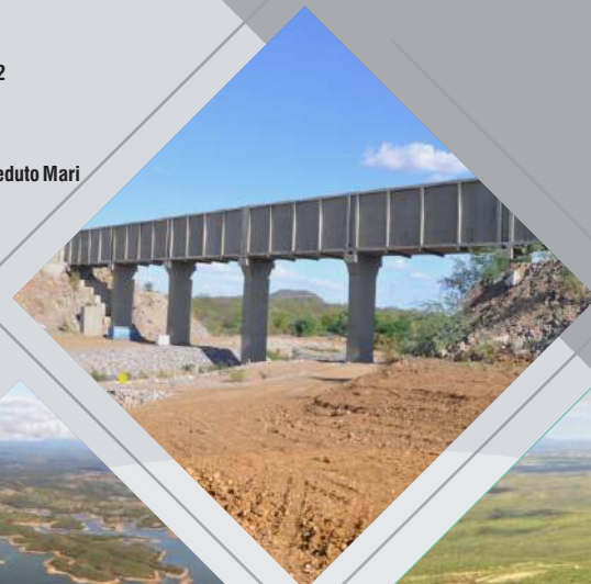
Estação de Bombeamento EBI-2
