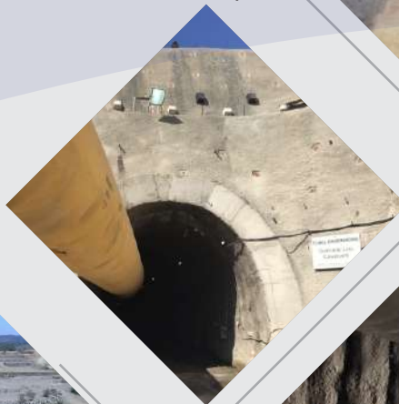
Túnel Eng. Giancarlo Lins Cavalcanti - Emboque
