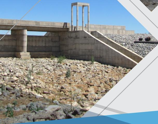
**Reservatório Moxotó:** Vertedouro concluído. Em fase de acabamento enrocamento do maciço.
