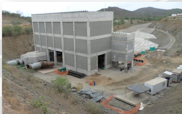
Estação de Bombeamento EBV-4.
