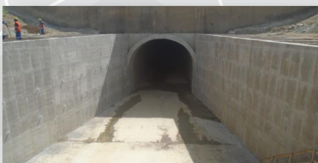
Túnel Cuncas II
