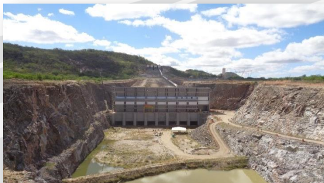
Execução da Estação de Bombeamento EBI-3
