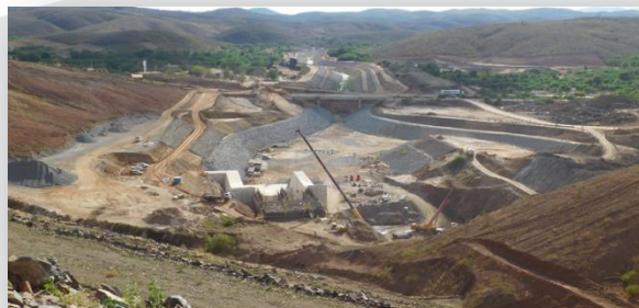
Reservatório Jati – vista do dique e maciço
