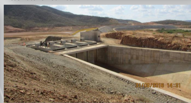
Estrutura de Controle Reservatório Caiçara
