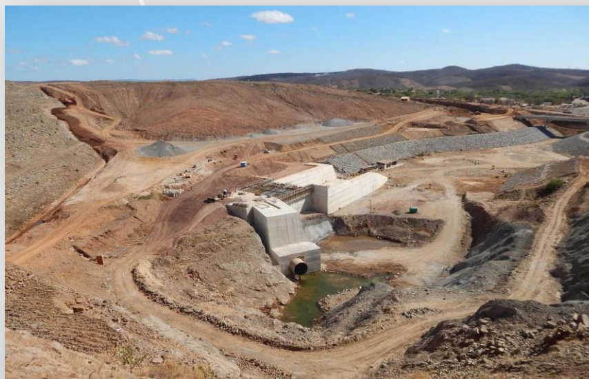
Construção da Tomada de água do Reservatório Jatí
