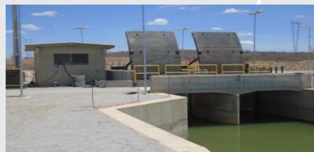
Estrutura de Controle do Reservatório Areias.
