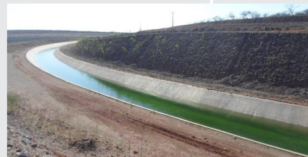
Canal entre EBV-1 e Res. Areias
