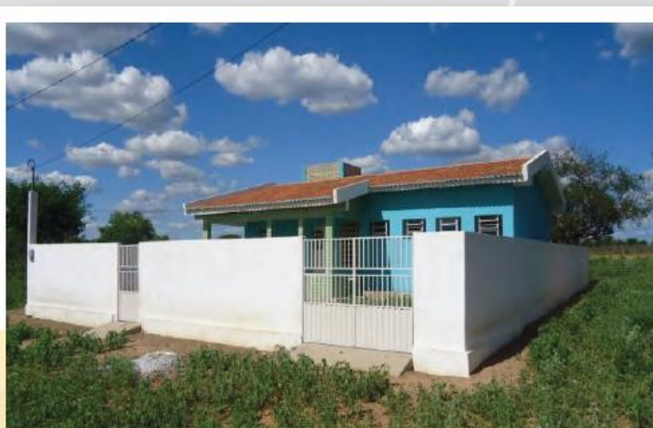
Posto de Saúde concluído, aldeia Caraibas, etnia Pipipã, município de Floresta – PE.
