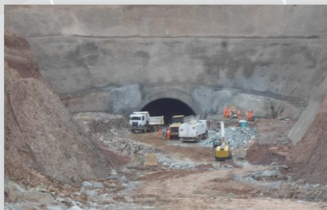
Emboque do túnel Milagres.
