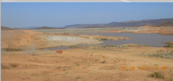
Reservatório Boa Vista
