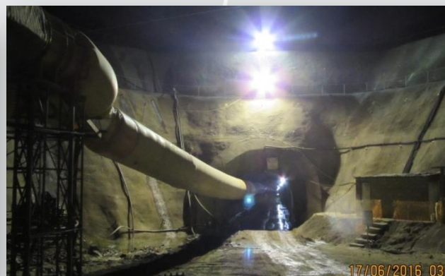
Túnel Eng. Giancarlo Lins Cavalcanti
