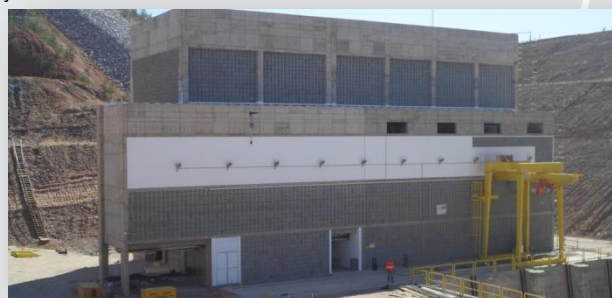
Estação de Bombeamento EBV-3
