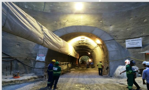
Túnel Eng. Giancarlo Lins Cavalcanti
