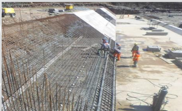
Vertedouro do Reservatório Milagres
