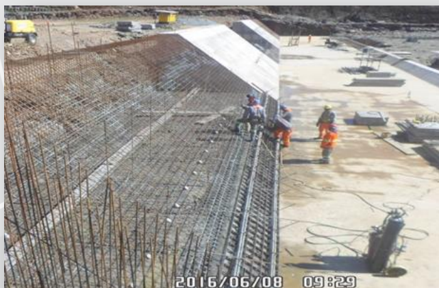
Vertedouro do Reservatório Milagres
