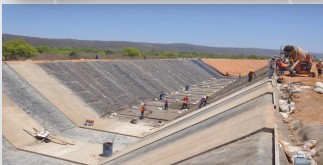
Segmento de canal entre Res. Morros e Boa Vista
