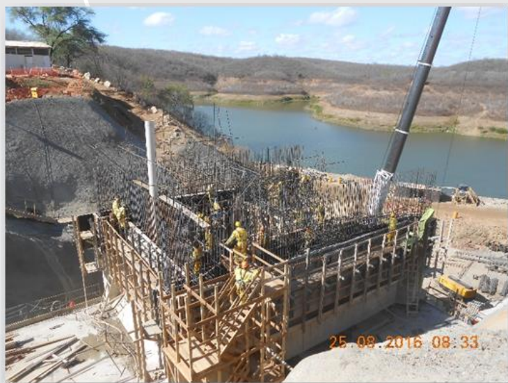
Construção da Tomada de água do Reservatório Atalho
