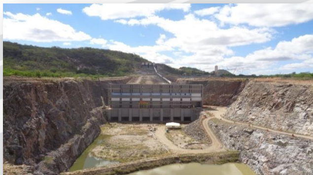
Execução da Estação de Bombeamento EBI-3
