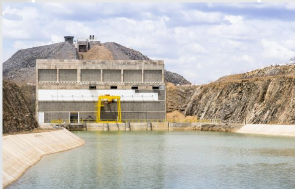
Estação de bombeamento EBV-2.
