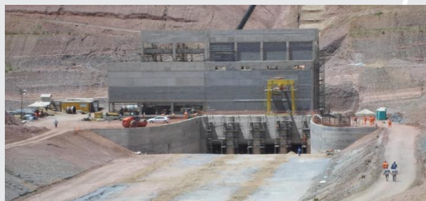
Estação de Bombeamento EBV-3
