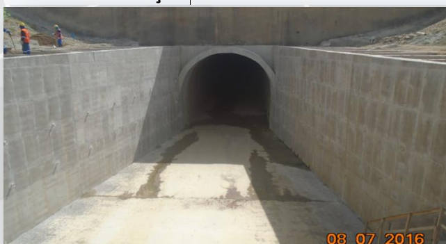
Túnel Cuncas II
