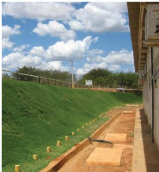
Talude revestido com gramineia para prevenção e controle de processo erosivo.
