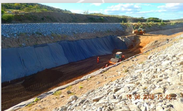
Segmento de Canal entre Túnel Giancarlo e Galeria Monteiro
