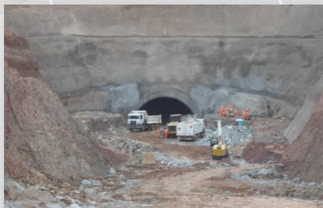
Emboque do túnel Milagres.
