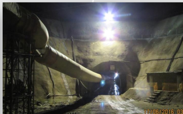
Túnel Eng. Giancarlo Lins Cavalcanti
