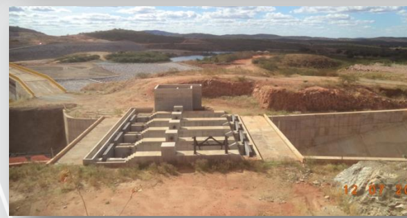
Estrutura de Controle Reservatório Caiçara
