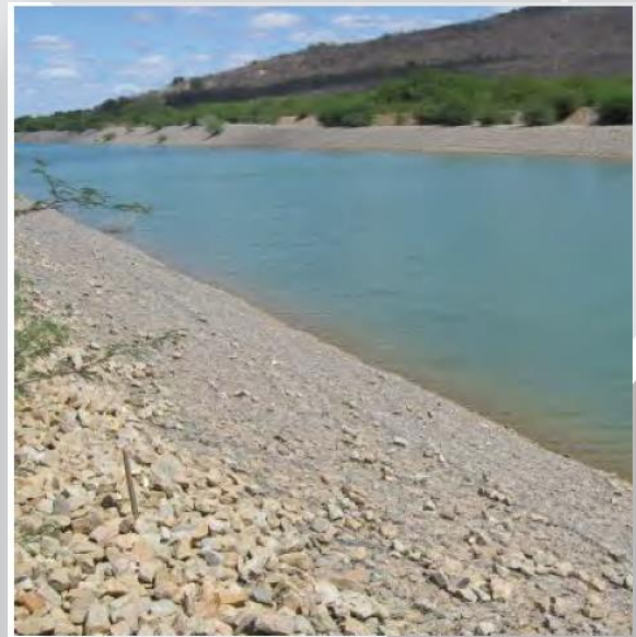
Colchão Reno implantado para contenção do talude do canal.
