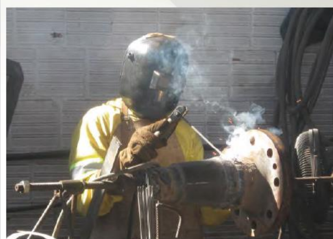
Colaborador executando atividade em oficina de solda do canteiro central de obras, utilizado EP's adequados para a atividade.
