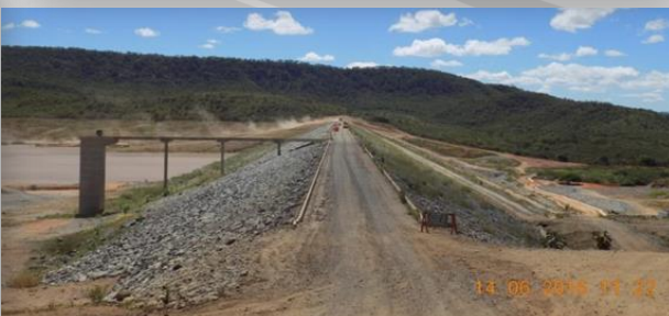
Reservatório Boa Vista
