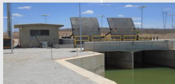
Estrutura de Controle do Reservatório Areias.
