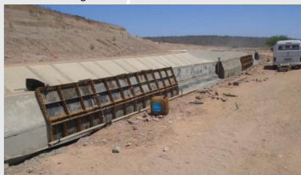
Segmento de Canal entre Reservatório Braúnas e Mandantes
