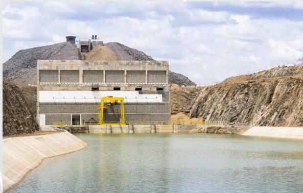
Estação de bombeamento EBV-2.
