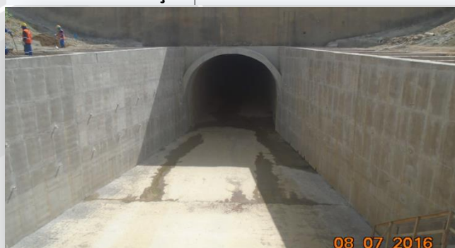
Túnel Cuncas II
