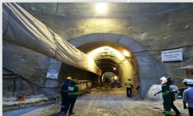
Túnel Eng. Giancarlo Lins Cavalcanti
