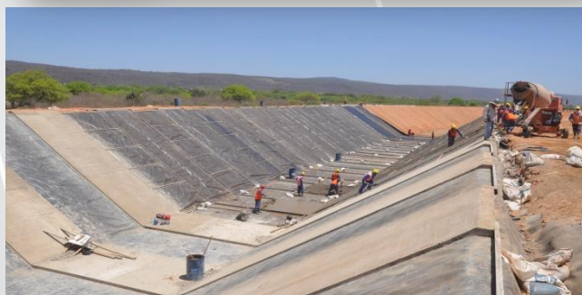
Segmento de canal entre Res. Morros e Boa Vista
