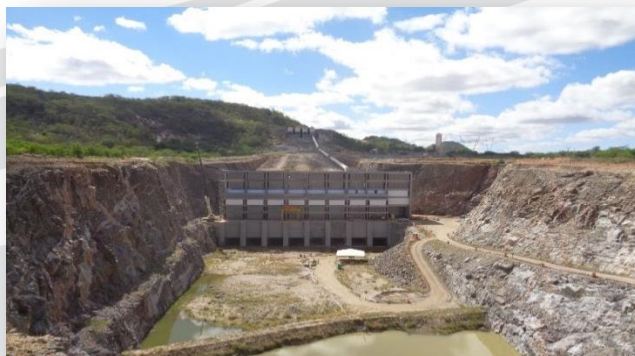
Execução da Estação de Bombeamento EBI-3
