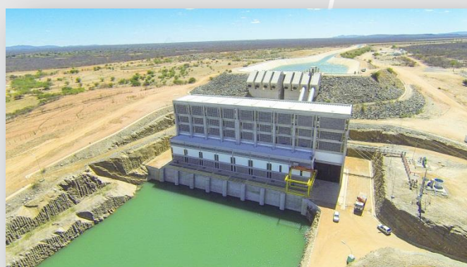
Estação de bombeamento EBI-1 em funcionamento.
