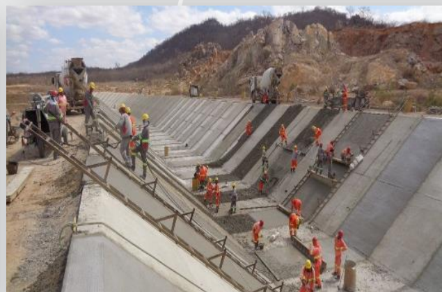
Execução de canal entre Res. Negreiros e Milagres.
