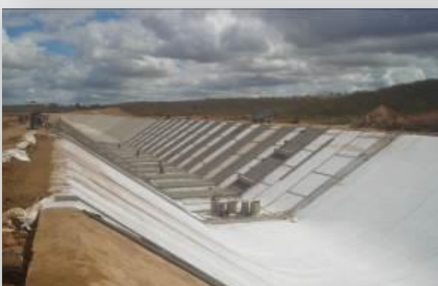
Execução de canal entre Galeria Penaforte e Res. Jati.
