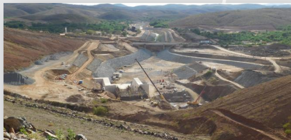
Reservatório Jati – vista do dique e maciço
