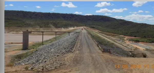
Reservatório Boa Vista
