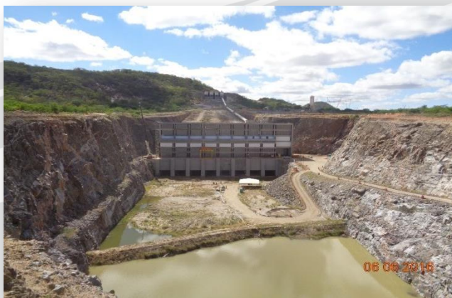
Execução da Estação de Bombeamento EBI-3
