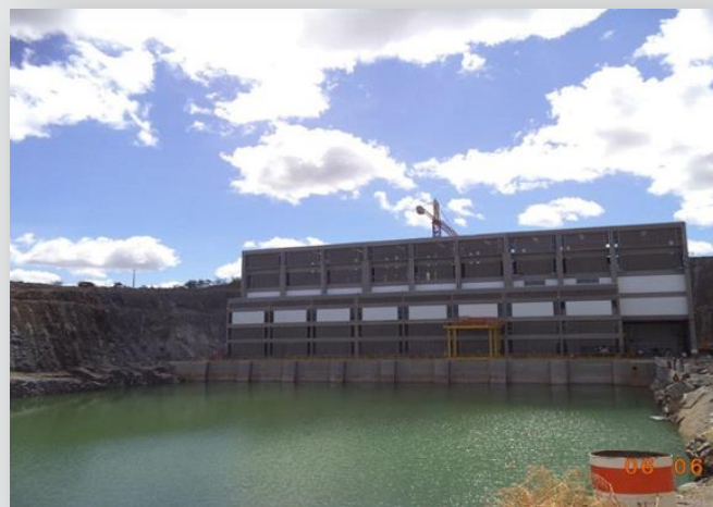
Estação de bombeamento EBI-2
