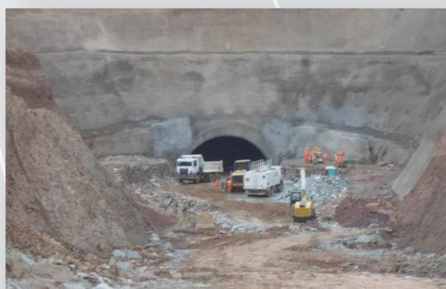
Emboque do túnel Milagres.
