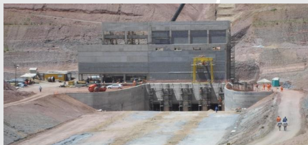
Estação de Bombeamento EBV-3
