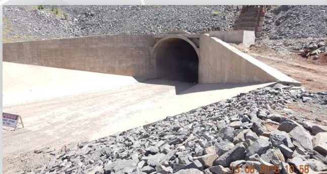
Túnel Cuncas I
