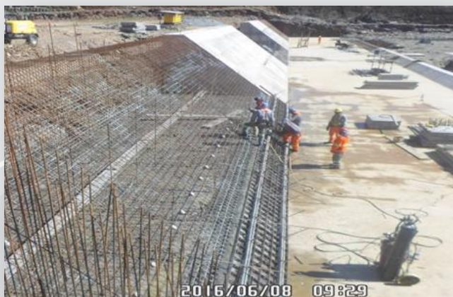
Vertedouro do Reservatório Milagres
