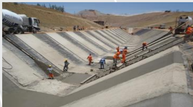
Segmento de canal entre reservatório Mandantes e EBV-3
