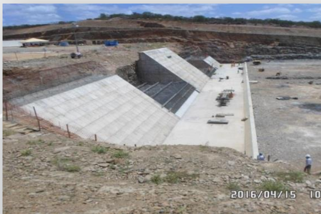
Vertedouro do Reservatório Milagres
