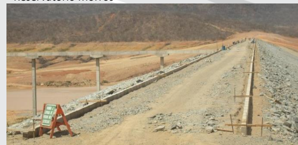
Reservatório Boa Vista
