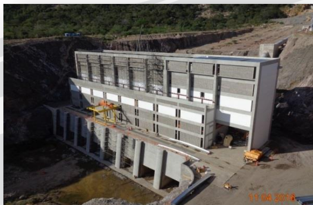
Execução da Estação de Bombeamento EBI-3
