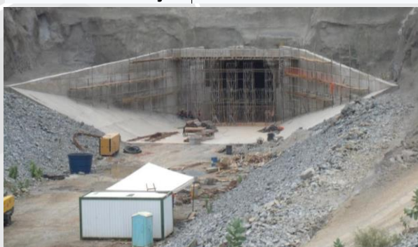
Túnel Cuncas I
