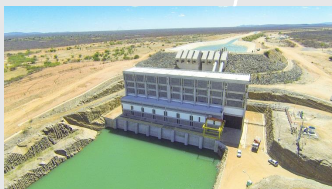
Estação de bombeamento EBI-1 em funcionamento.
