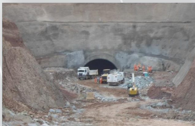
Emboque do túnel Milagres.
