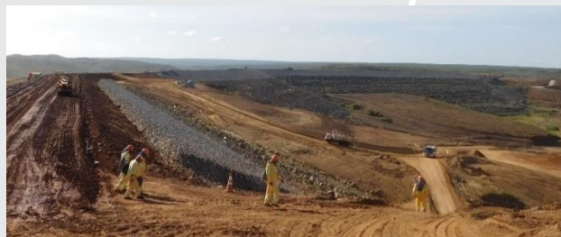
Reservatório Jati – vista do dique e maciço
