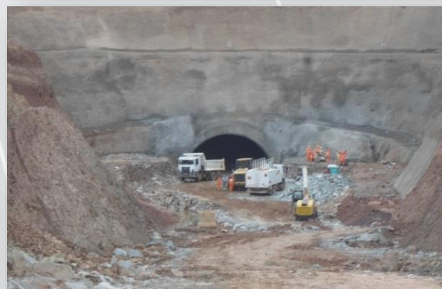
Emboque do túnel Milagres.
