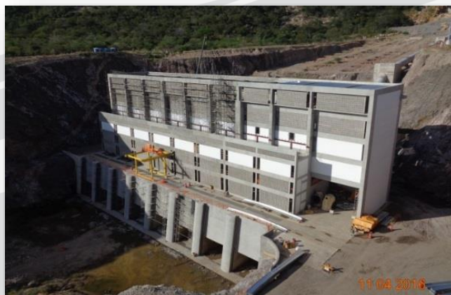
Execução da Estação de Bombeamento EBI-3
