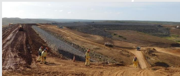
Reservatório Jati – vista do dique e maciço
