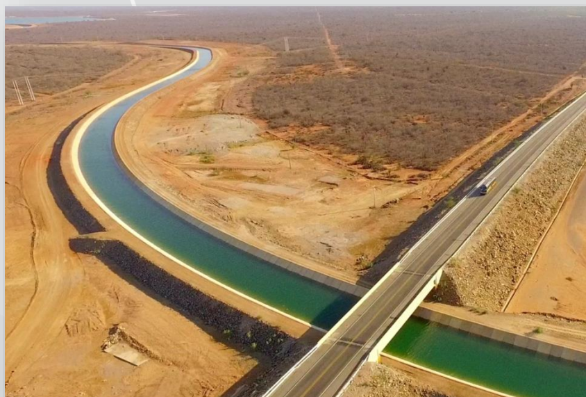
Segmento de Canal entre a EBI-1 e Reservatório Tucutu
