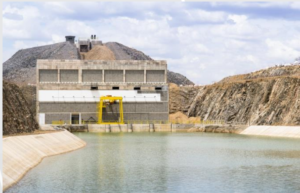
Estação de bombeamento EBV-2.
