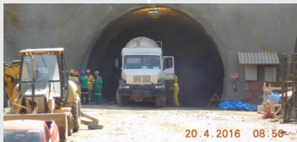
Escavação do túnel da tomada de água do Res. Atalho
