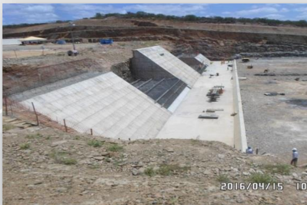
Vertedouro do Reservatório Milagres
