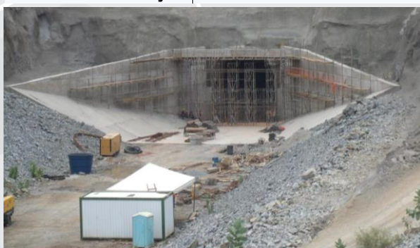
Túnel Cuncas I
