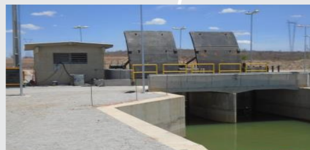
Estrutura de Controle do Reservatório Areias.
