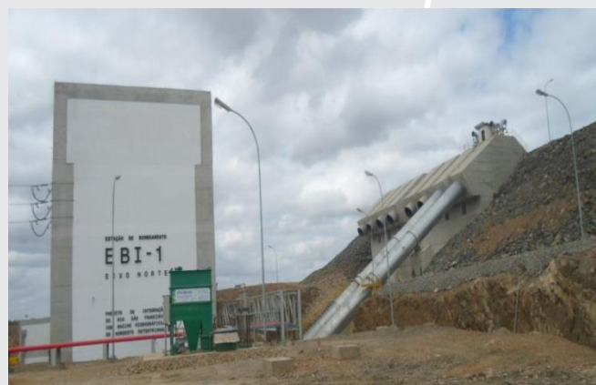
Estação de bombeamento EBI-1 em funcionamento.
