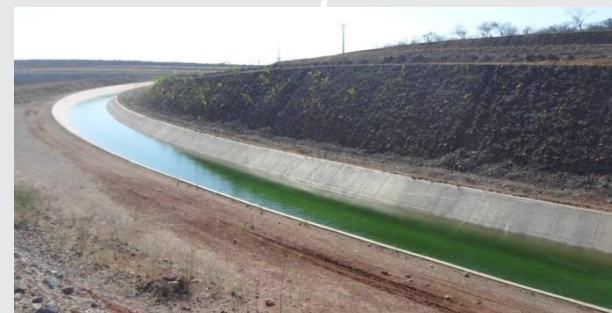
Canal entre EBV-1 e Res. Areias
