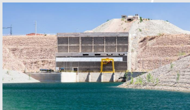
Vista interna da EBV-1.
