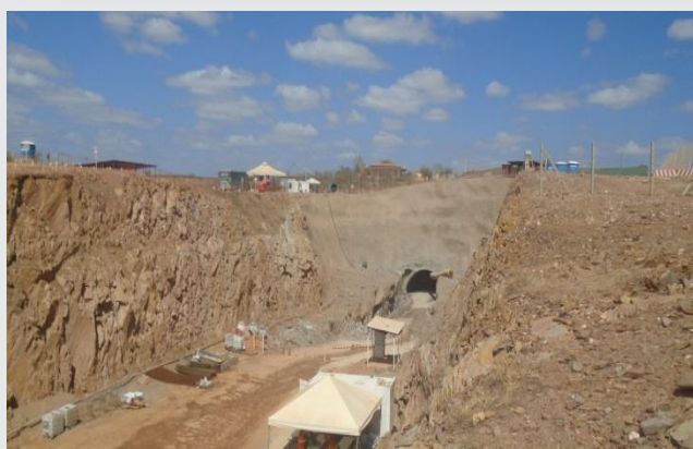
Emboque do túnel Milagres.
