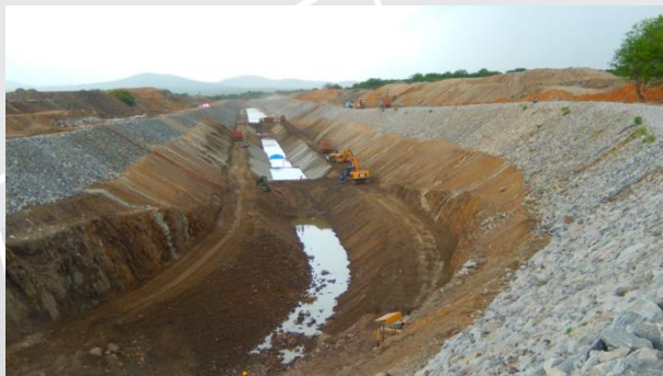
Segmento de Canal entre Túnel Giancarlo e Galeria Monteiro
