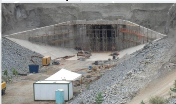
Túnel Cuncas I
