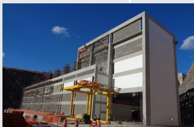
Execução da Estação de Bombeamento EBI-3
