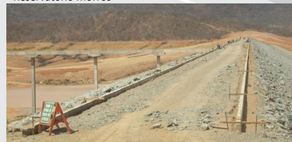
Reservatório Boa Vista
