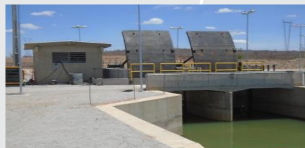
Estrutura de Controle do Reservatório Areias.
