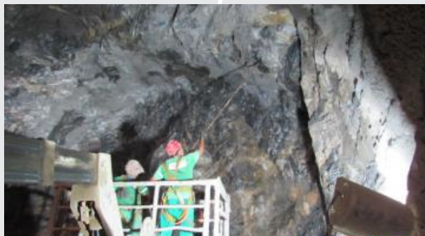
Túnel Eng. Giancarlo Lins Cavalcanti
