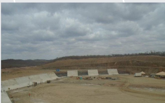
Vertedouro do Reservatório Milagres
