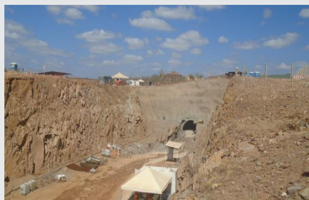
Emboque do túnel Milagres.
