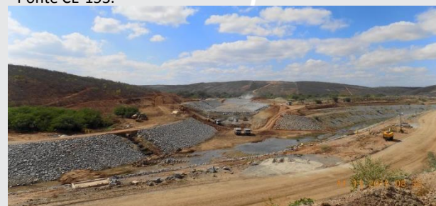
Segmento de Canal entre Jati e Atalho
