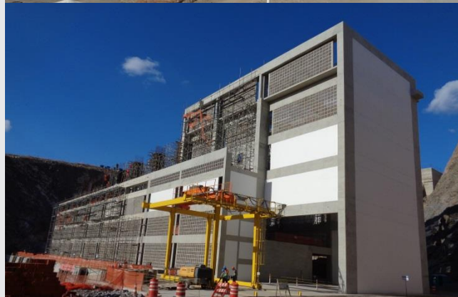
Execução da Estação de Bombeamento EBI-3
