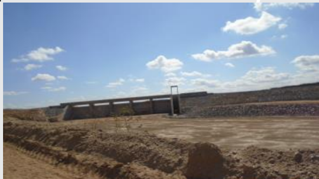
Reservatório Barro Branco
