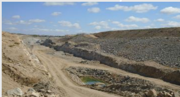
Canal entre o Res. Barro Branco e o Túnel Giancarlo
