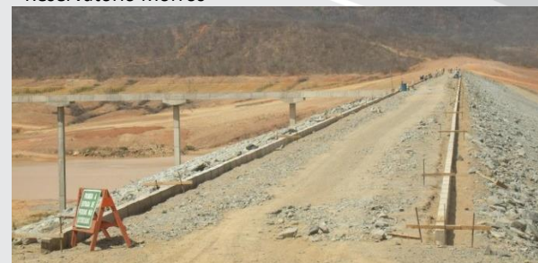
Reservatório Boa Vista
