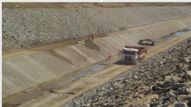
Segmento de Canal entre Túnel Giancarlo e Aduтора Monteiro
