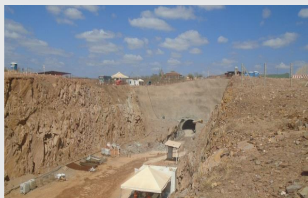
Emboque do túnel Milagres.
