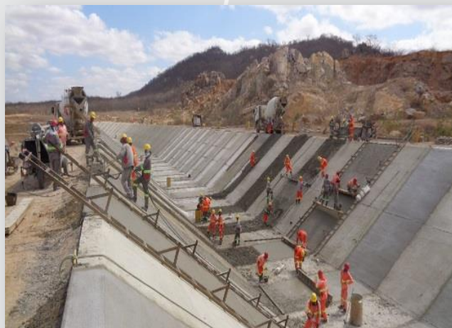
Execução de canal entre Res. Negreiros e Milagres.
