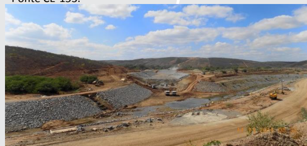
Segmento de Canal entre Jati e Atalho
