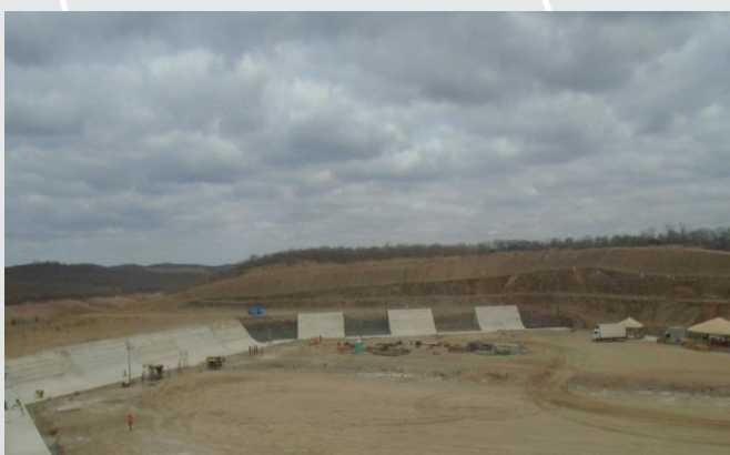
Vertedouro do Reservatório Milagres
