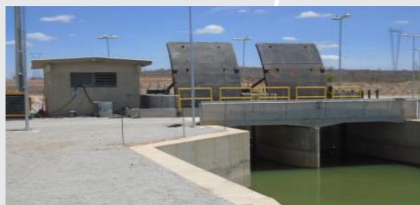
Estrutura de Controle do Reservatório Areias.
