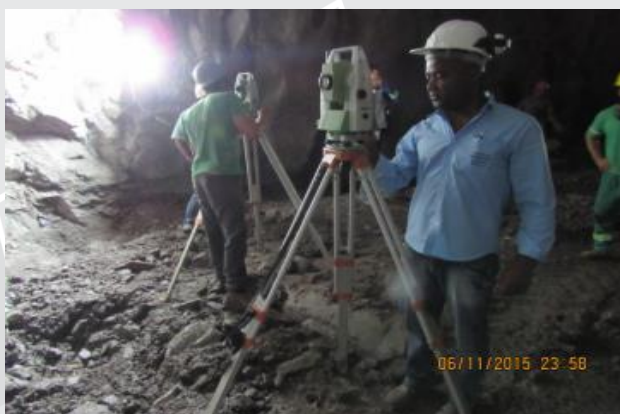
Túnel Eng. Giancarlo Lins Cavalcanti
