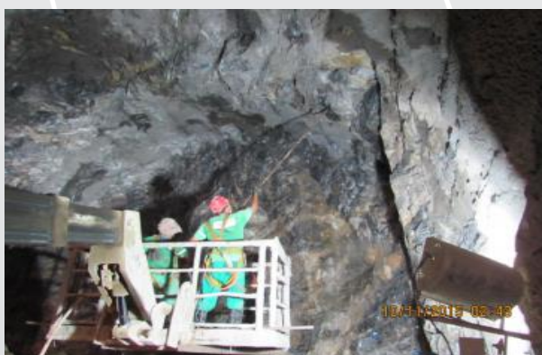
Túnel Eng. Giancarlo Lins Cavalcanti
