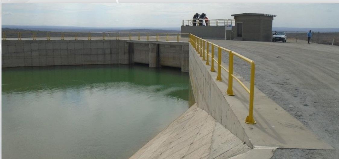
Bombeamento na EBV-2, conduzindo água para Reservatório Braúnas.
