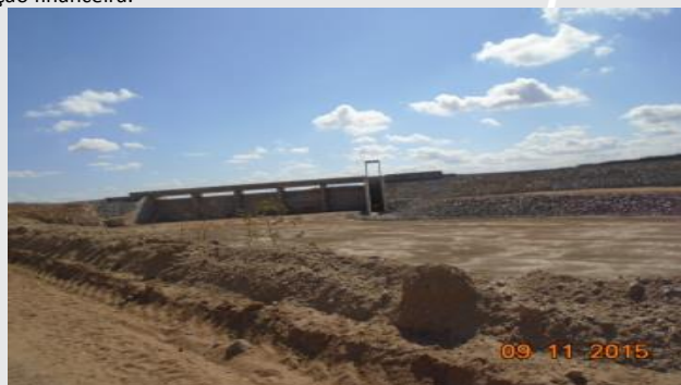
Reservatório Barro Branco
