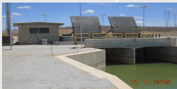
Estrutura de Controle do Reservatório Areias.
