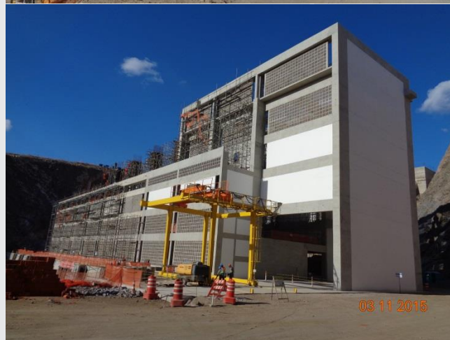
Execução da Estação de Bombeamento EBI-3
