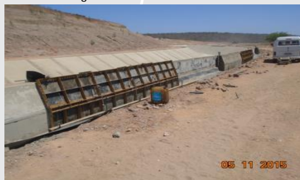
Segmento de Canal entre Reservatório Braúnas e Mandantes
