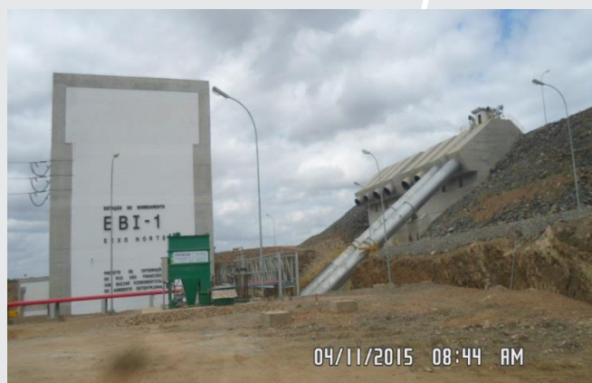
Estação de bombeamento EBI-1 em funcionamento.
