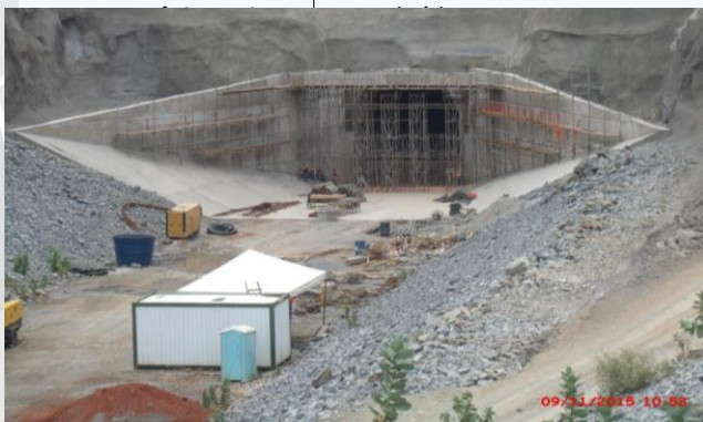
Túnel Cuncas I
