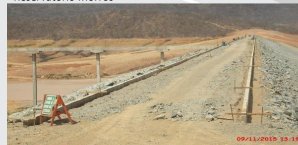
Reservatório Boa Vista
