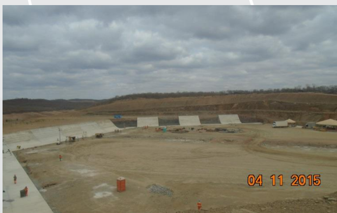
Vertedouro do Reservatório Milagres
