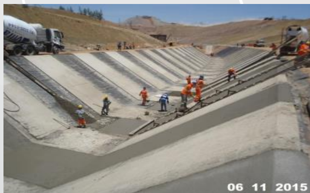
Segmento de canal entre reservatório Mandantes e EBV-3
