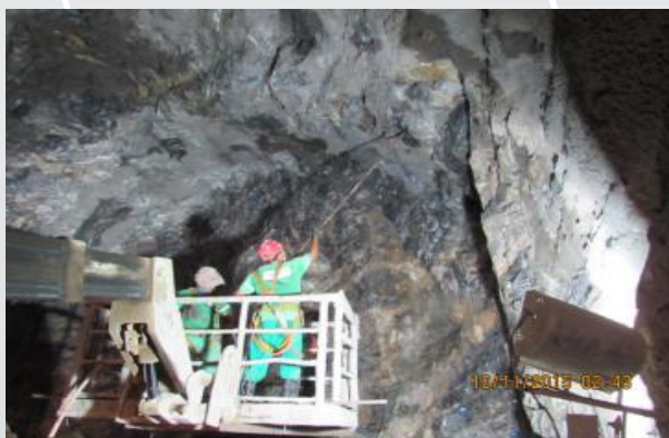
Túnel Eng. Giancarlo Lins Cavalcanti
