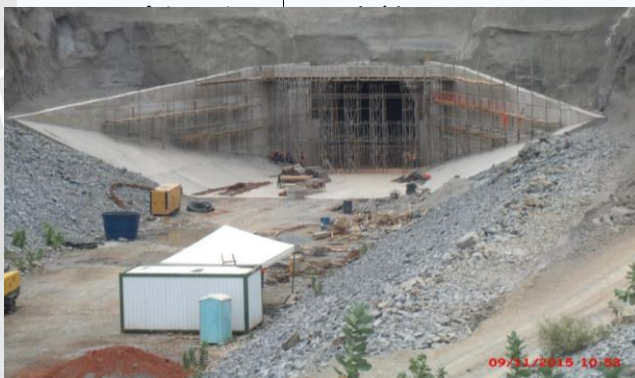
Túnel Cuncas I
