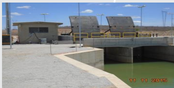
Estrutura de Controle do Reservatório Areias.
