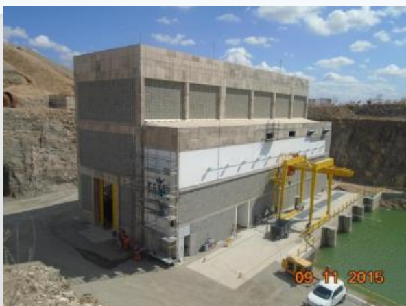
Estação de bombeamento EBV-2.
