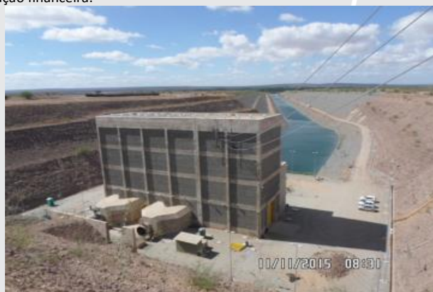
Vista interna da EBV-1.
