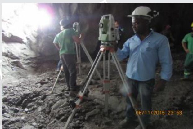
Túnel Eng. Giancarlo Lins Cavalcanti
