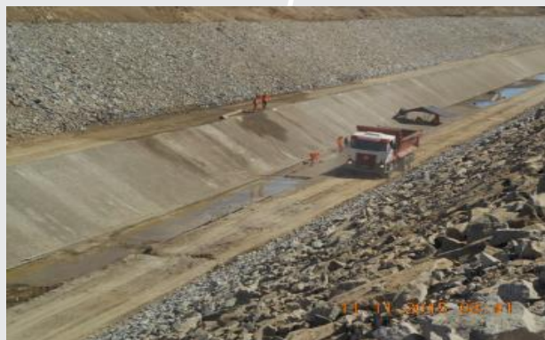
Segmento de Canal entre Túnel Giancarlo e Adutora Monteiro
